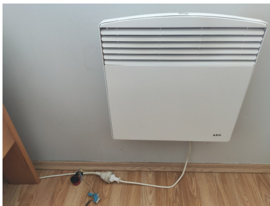
Obrázek 2.1: Fotografie přímotopného konvektoru AEG WKL 1003 U instalovaného v malém pokoji v jednopodlažním rodinném domě.
