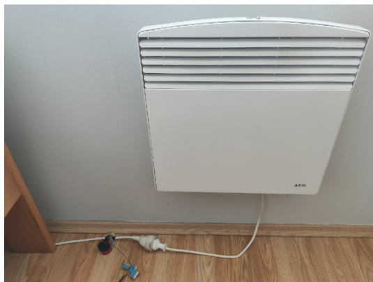
Obrázek 2.1: Fotografie přímotopného konvektoru AEG WKL 1003 U instalovaného v malém pokoji v jednopodlažním rodinném domě.
