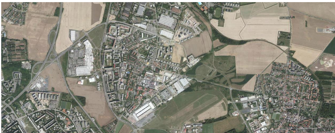
Obrázek 3: Praha - Letňany v roce 2010 ( https://kontaminace.cenia.cz upravil Vršecký 2018).
