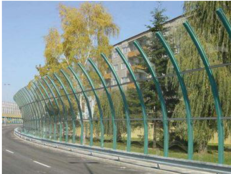
Obrázek 23 – Automobilová protihluková stěna; Zdroj: Autor
