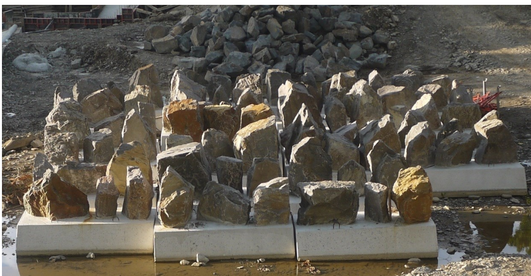
Obr. č. 8 – Možnosti rozložení lomového kamene zapuštěného do betonových bloků, tyto celky zjednodušují instalaci v trati RP. Foto: RNDr. Milan Hladík, PhD.
