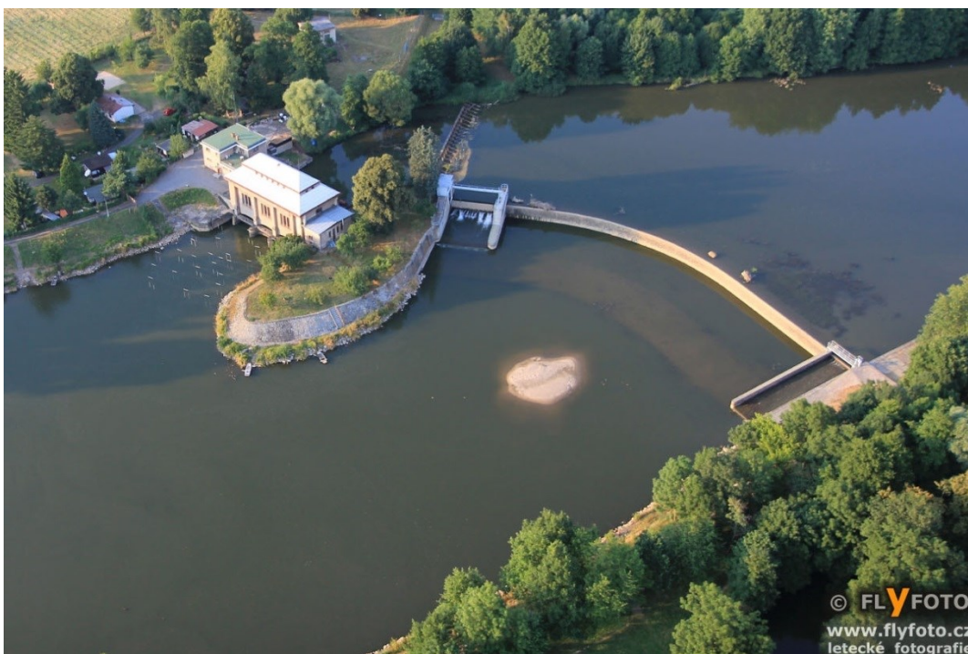
Obr. P-1 – Pohled na Malšovický jez s vorovou propustí a přílehlou MVE [8]
