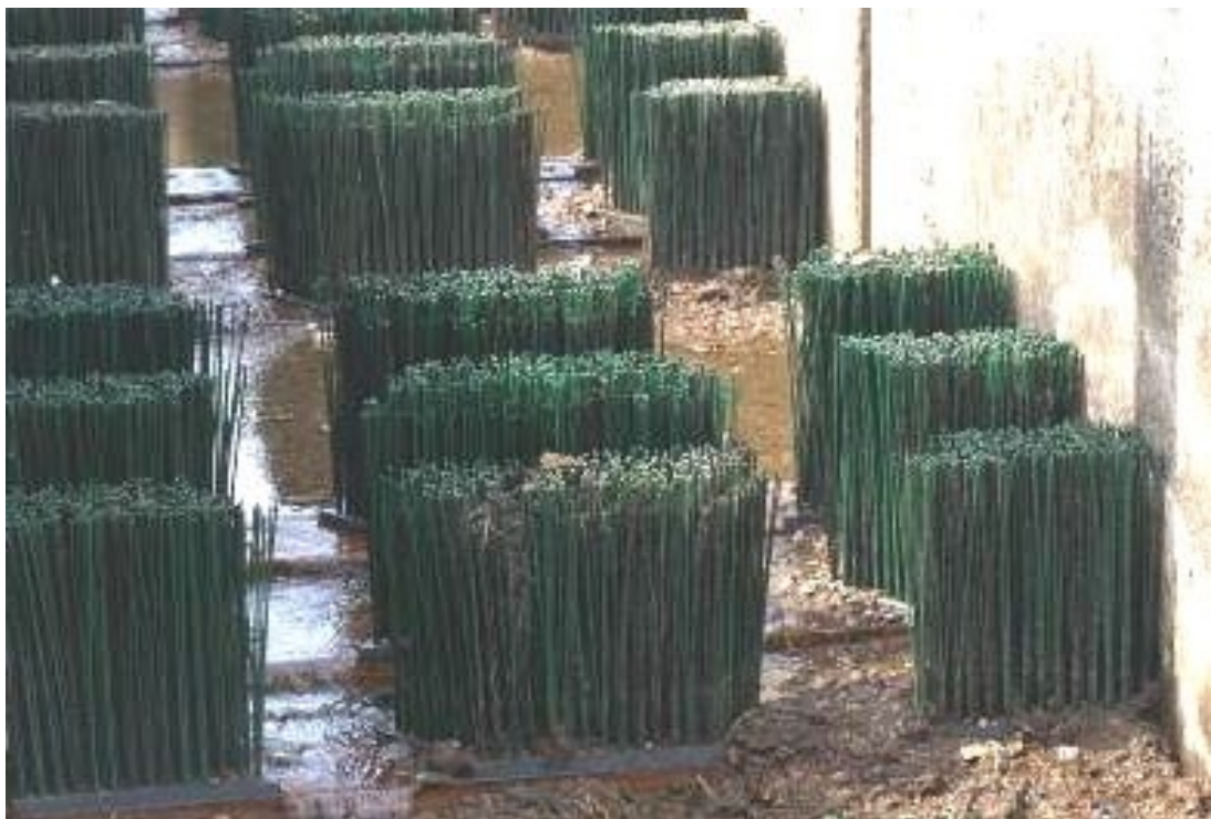
Obr. P-8 – Elastické plastové štěrby, které jsou hojně využívány při rekonstrukcích sportovních propustí na rybí přechody [Horký P. a kol., 2013]
