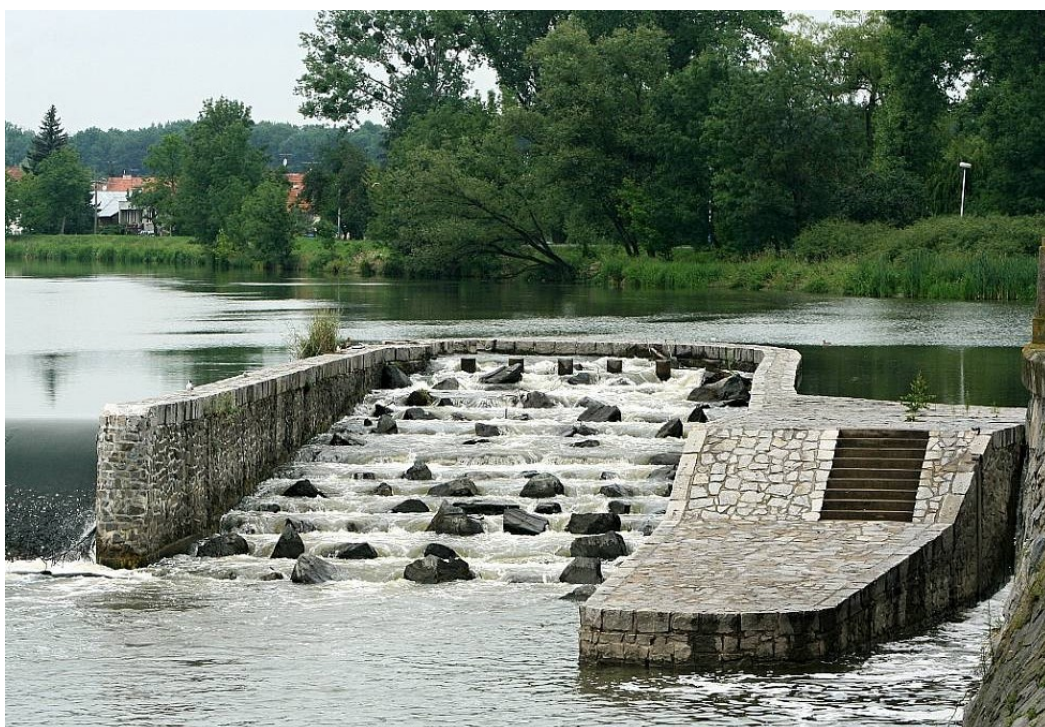
Obr. P-2 – Migrační rampa zbudovaná v Břeclavi na řece Dyji, která sloužila jako inspirace pro můj návrh [1]
