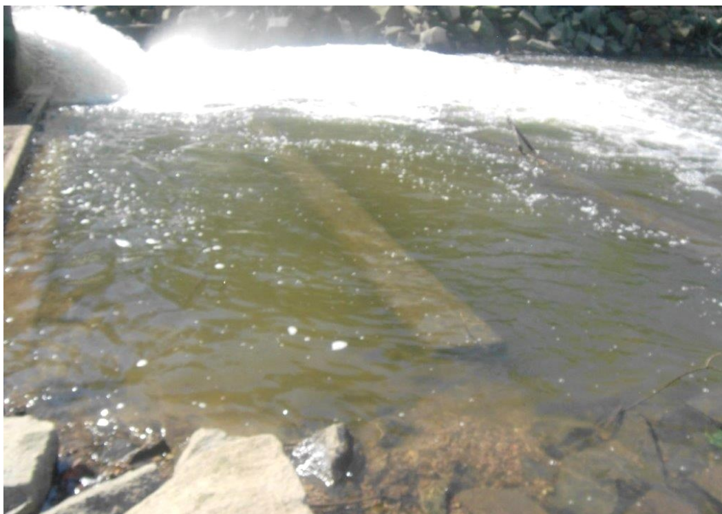
Obr. P-3 – Pohled na dřevěné rošty pod vorovou propustí. Foto: Pavel Herodes.
