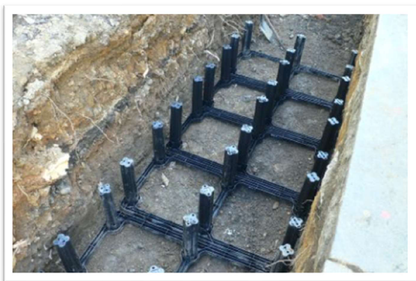
Obr. 14 Prokořenitelné buňky při realizaci projektu v Budečské ulici (foto DO PARKU)
