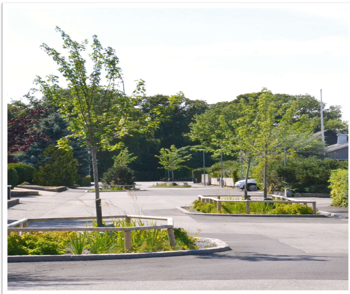
Obr. 9 Livable streets – A handbook of Bluegreengrey systems – Edge Po instalaci MZŠI a bioretenční oblasti
