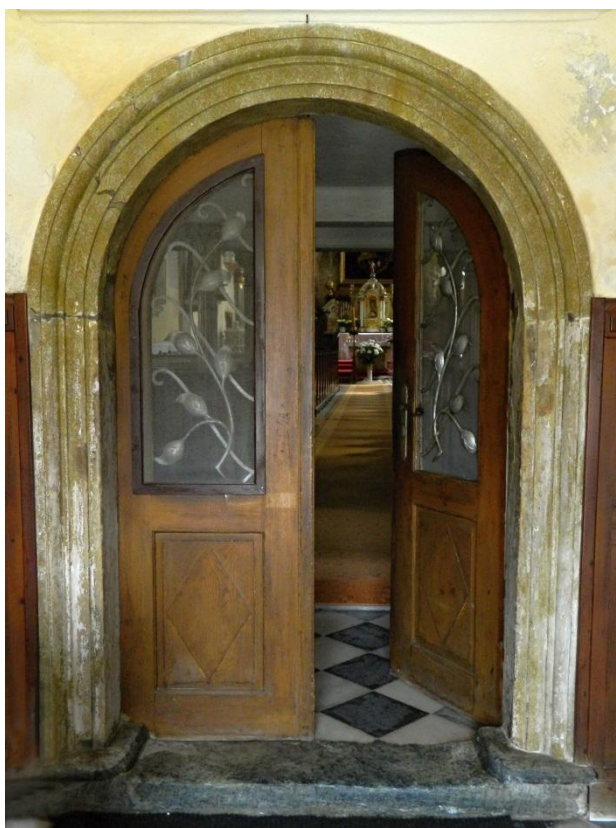
16. Sobotín, Kostel sv. Vavřince, vstupní portál z předsíně pod věží
