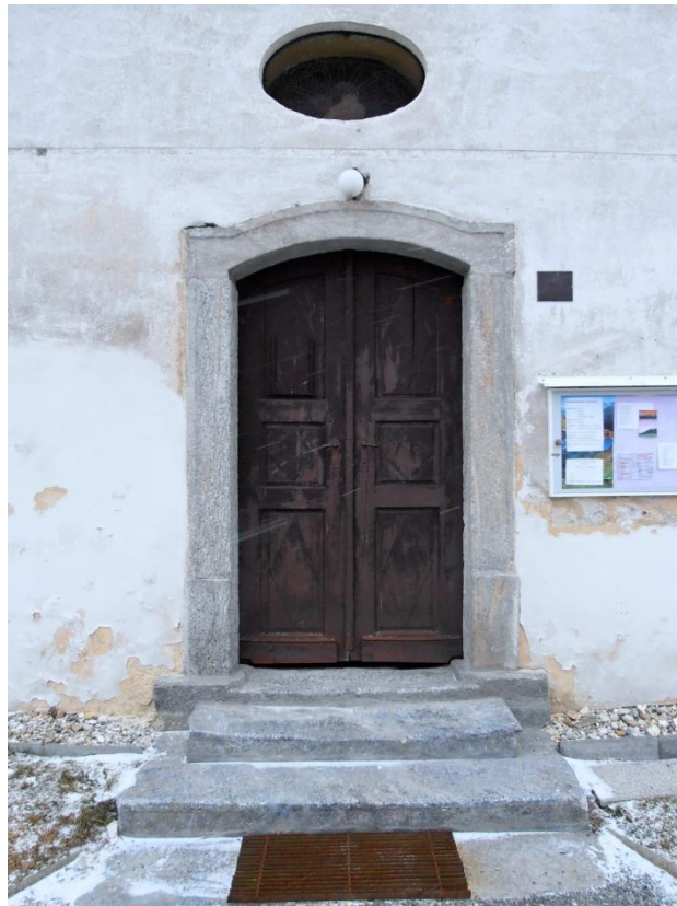
13. Sobotín, Kostel sv. Vavřince, portál hlavního vstupu
