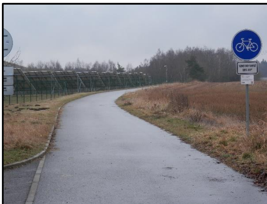
Foto č. 11.: Nová asfaltová a cesta HPC 2.
