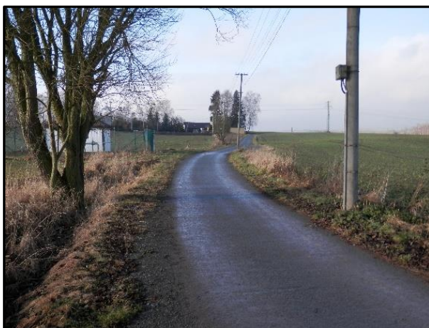
Foto č. 14.: Vyspravená cesta HPC 6 a založená doprovodná vegetace.
