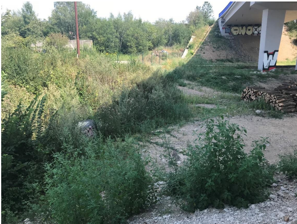
Obrázek č. 1 – Pohled na prostor volné skládky, kde jsou v nově navrženém stavu situovány manipulační koleje č. 6a a č. 8.
