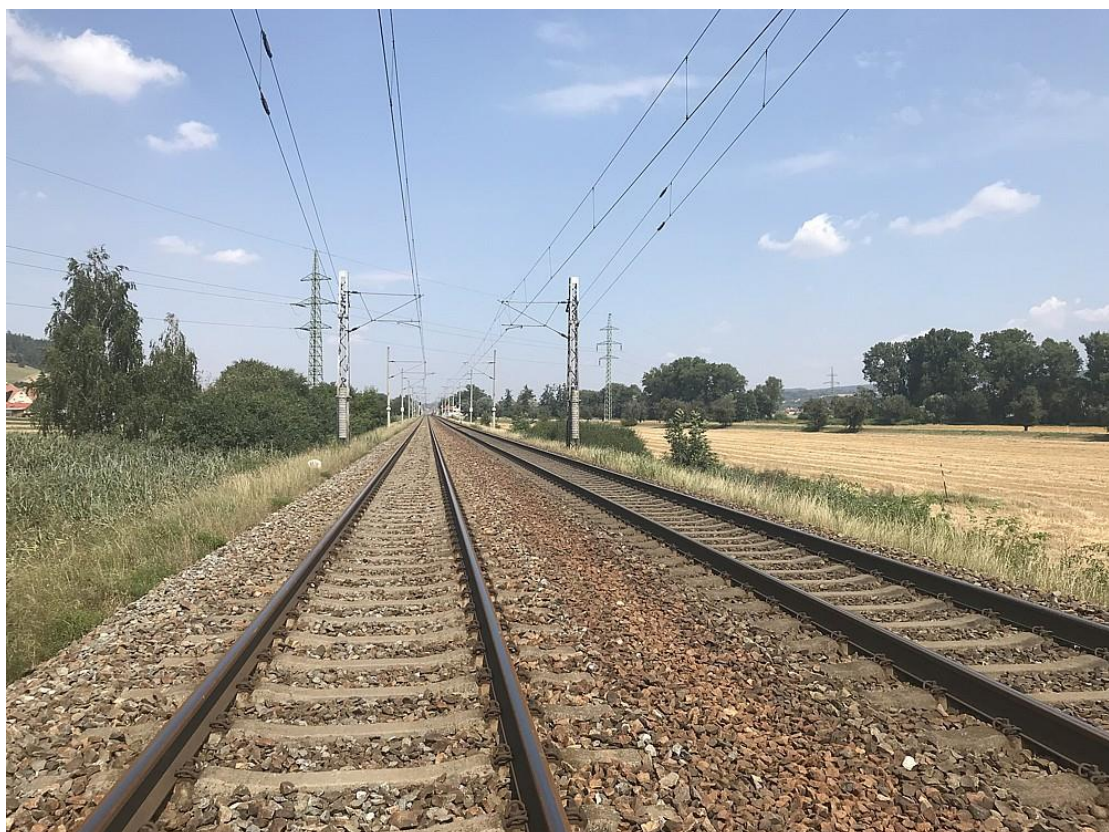
Obrázek č. 2 – místo nového silničního nadjezdu v rámci přeložky silnice III/37435
