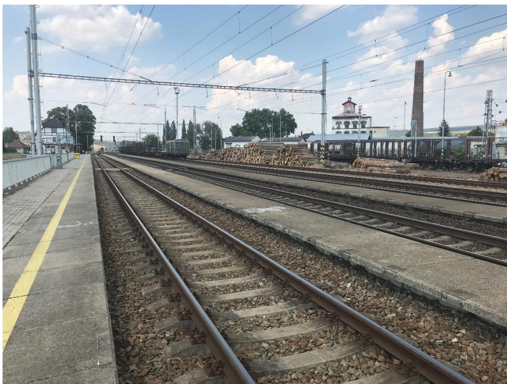
Obrázek č. 2 – Pohled na stávající nástupiště v žst. Rájec-Jestřebí
