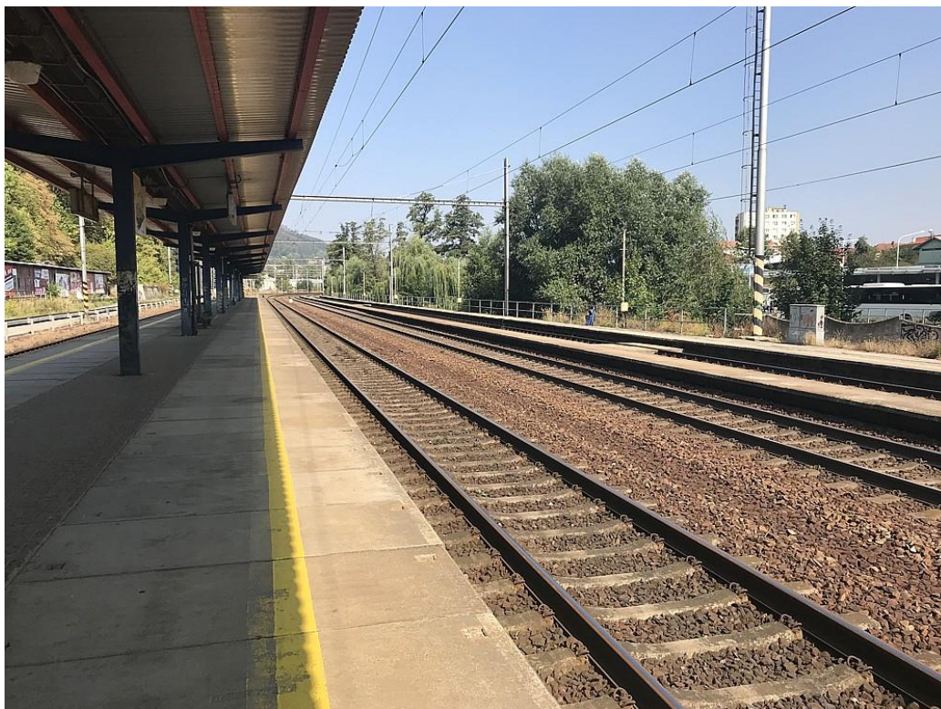
Obrázek č. 1 – Pohled na nástupiště a kolejiště v žst. Blansko
