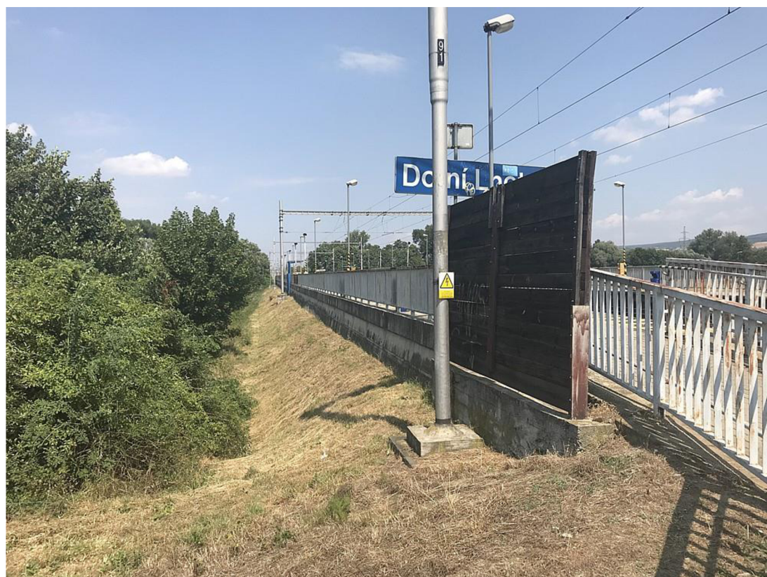
Obrázek č. 4 – rušená zast. Dolní Lhota
