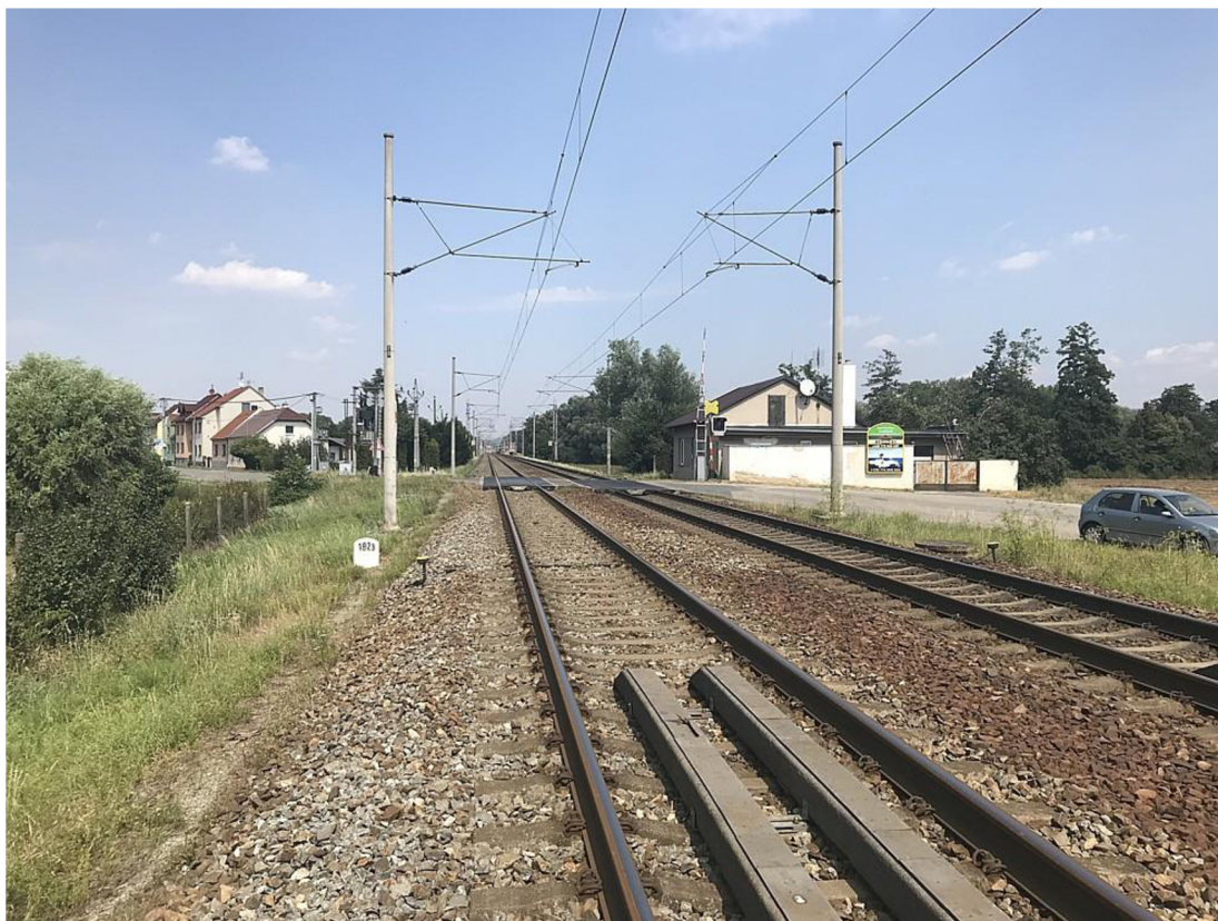
Obrázek č. 3 – rušený přejezd P6803, demolice objektu č.p. 34 a poloha nové zast. Dolní Lhota
