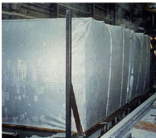
Obrázek 9: Propařování betonového prvku pod PE fólií [30]
