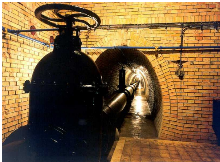
Obr. 20 Štola násosky I. březovského vodovodu v prameništi Březová nad Svitavou [16]
