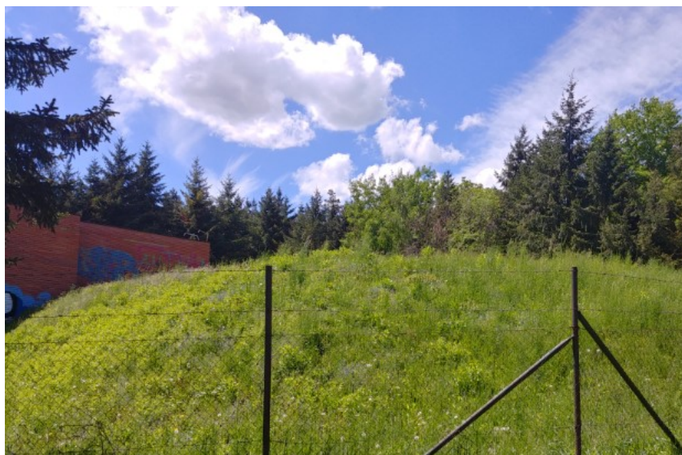
Obr. 48 TP Líšeň Vodojem 2/2
