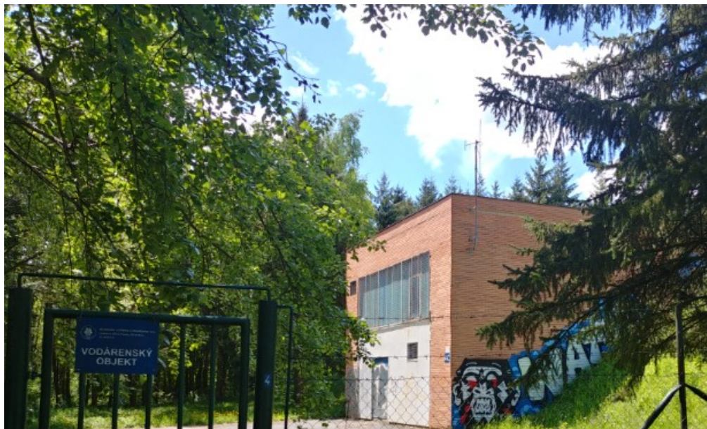
Obr. 47 TP Líšeň Vodojem 1/2
