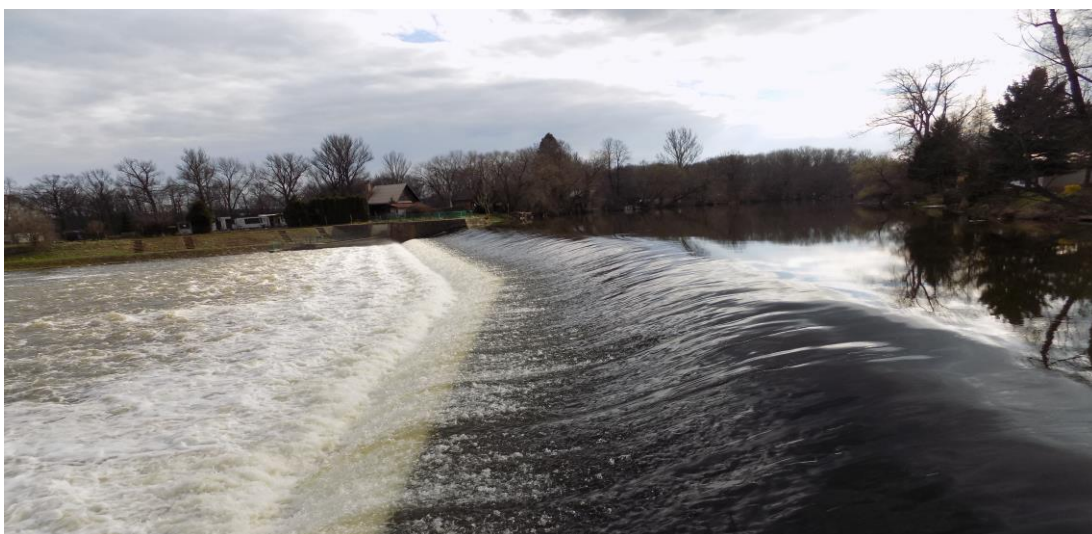
Fotografie č. 6: Jez na řece Ohři, v dálce s viditelným rybím přechodem (zdroj: Autor, 2015).
