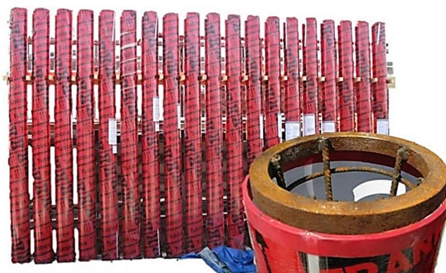
obrázek 36 - Výroba zkušebních vzorků – pohled na papírové bednění včetně umístění armokoše
