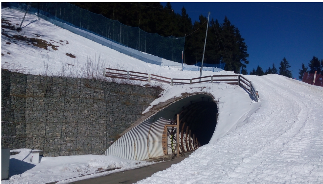
Obr. 3.6: Masa sněhu působící na tunel [14]
