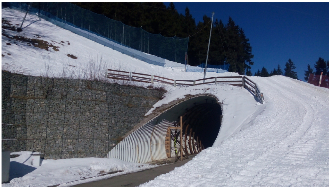
Obr. 3.6: Masa sněhu působící na tunel [14]
