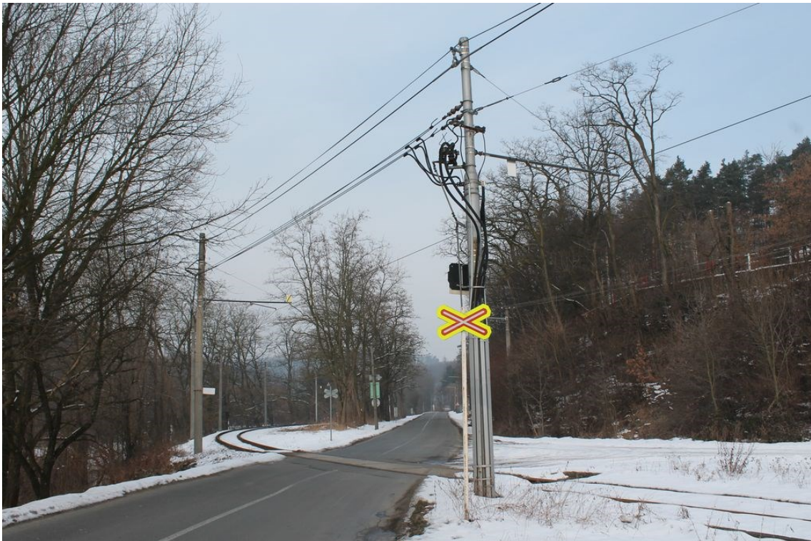
Obr. 2.1: Tramvajová trať překračující silnici – Plzeň
