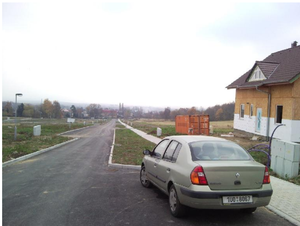
Foto č. 7: Dokončení ulice
