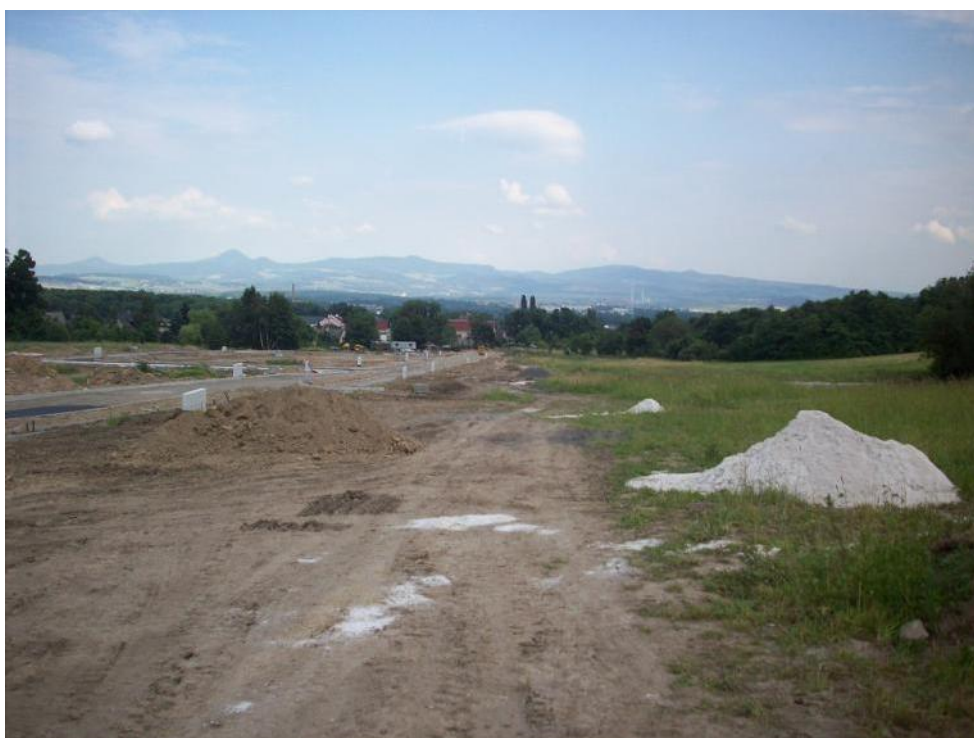
Foto č. 6: Výstavba ulice
