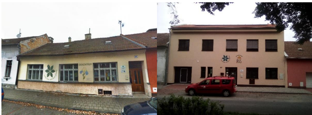
Obr. 42: Stará a nová budova ekocentra Iris (zdroj: Magistrát města Prostějova, 2021 a autor, 2023)
