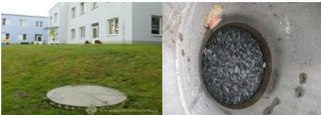
Obr. 33: Vsakovací šachta v Plzni v mateřské škole na ul. Staniční (zdroj: Envic, 2023)
