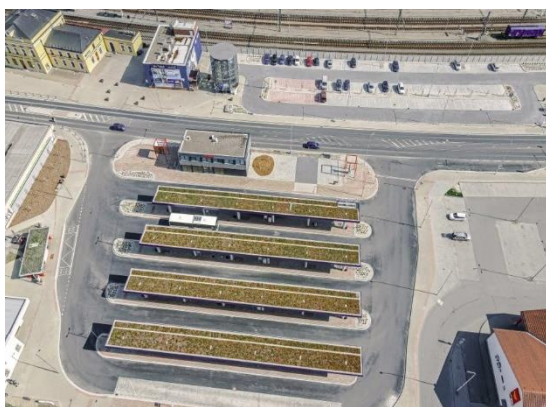
Obr. 12: Vegetační střechy v Šumperku na autobusovém nádraží (zdroj: Nadace Partnerství, 2021b)
