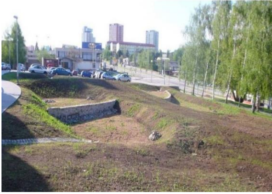
Obr. 31: Vsakovací průleh-rýha v Brně na ul. Chalabalova (zdroj: JV Projekt VH, 2010)
