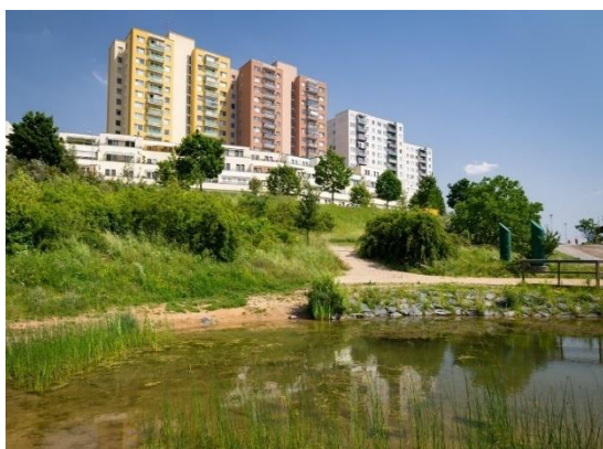
Obr. 20: Retenční nádrž se stálou hladinou vody v Brně v parku Pod Plachtami (zdroj: Magistrát města Brna, 2013)
