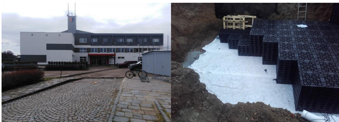
Obr. 28: Budova Sportcentra v Prostějově a vsakovací nádrž složená z bloků v průběhu instalace (zdroj: Magistrát města Prostějova, 2021)
