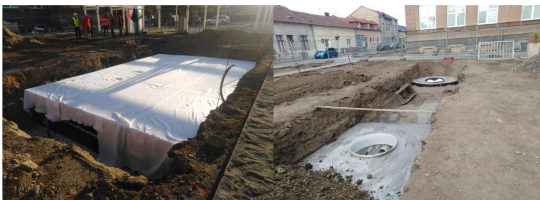
Obr. 36: Retenční nádrž a akumulací nádrž se vsakovací šachtou (zdroj: Magistrát města Prostějova, 2022)
