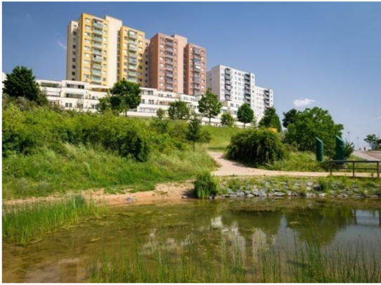
Obr. 20: Retenční nádrž se stálou hladinou vody v Brně v parku Pod Plachtami (zdroj: Magistrát města Brna, 2013)
