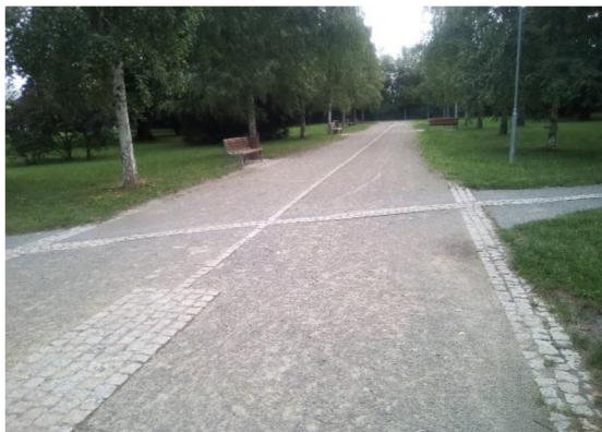
Obr. 4: Mlatové plochy v Kolářových sadech v Prostějově (zdroj: autor, 2023)
