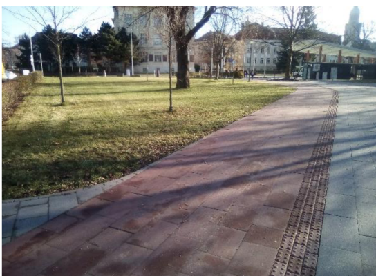
Obr.24: Plošný vsak v Prostějově na Floriánském náměstí (zdroj: autor, 2023)
