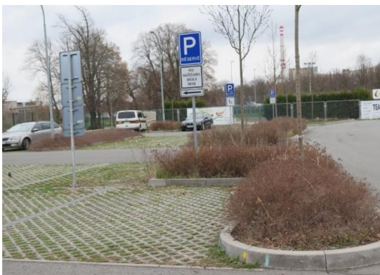
Obr. 6: Propustné zpevněné plochy v Plzni na ul. Pallova (zdroj: Magistrát města Plzně)
