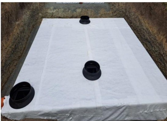
Obr. 14: Akumulační nádrž v průběhu instalace v MŠ Smetanova v Prostějově (zdroj: Magistrát města Prostějova, 2023b)
