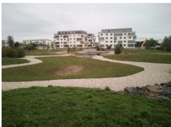
Obr. 40: Vsařovací průleř v Mládkových sadech (zdroj: autor, 2023)
