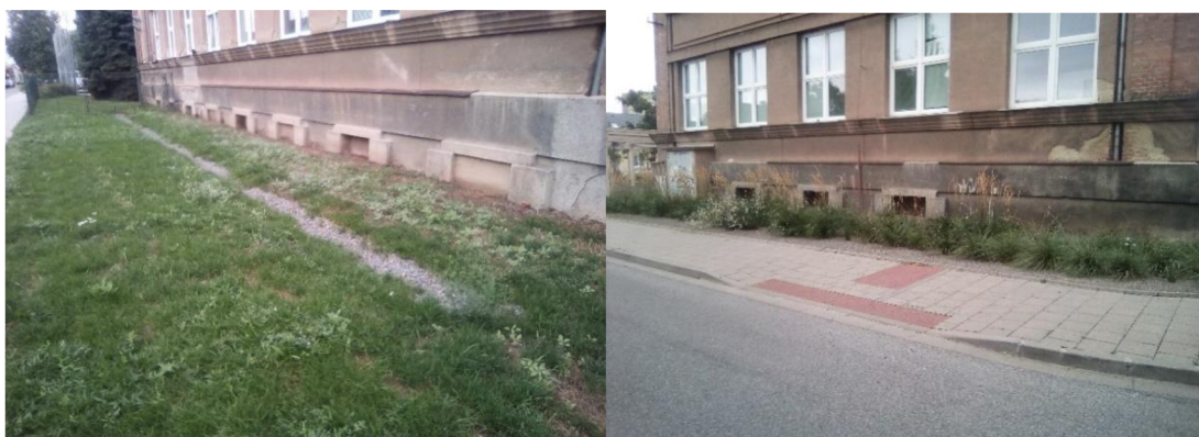
Obr. 37: Vsakovací průlehy u jižní a východní strany budovy (zdroj: autor, 2023)
