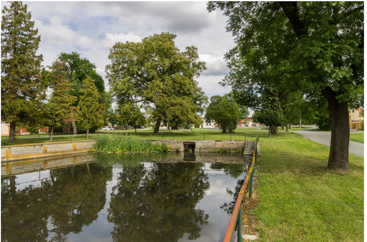
LUC002 – Požární nádrž v obci Přehýšov
