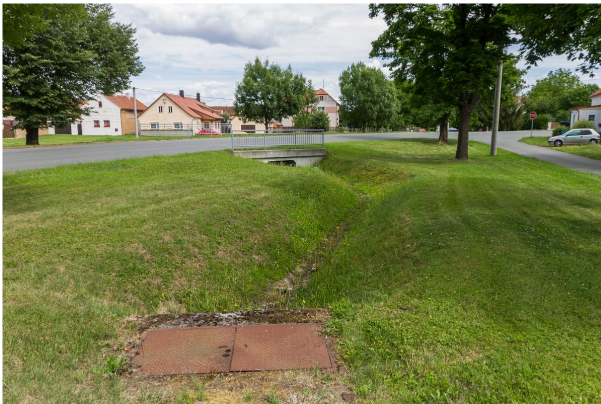
LUC002 – Zatravněný průleh pod komunikací v obci Přehýšov
