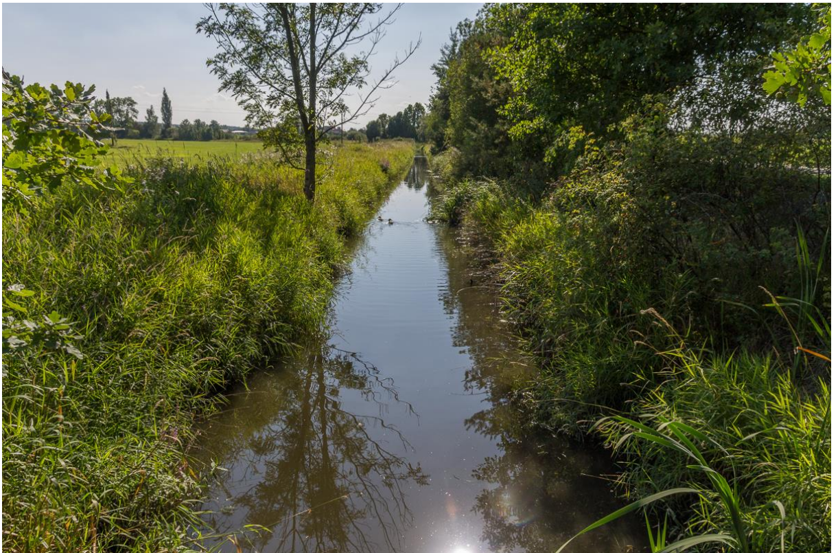
LUC016 – Pohled na napřímené a rozšířené koryto Lučního potoka za přítokem Zálužského potoka a ČOV Líně
