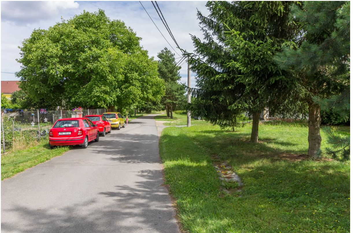
LUC002 – Svod povrchové vody na konci obce Přehýšov
