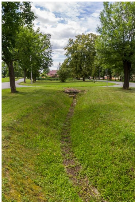
Obr. č. 7.4-1 Zatrubněný úsek v obci Přehýšov
