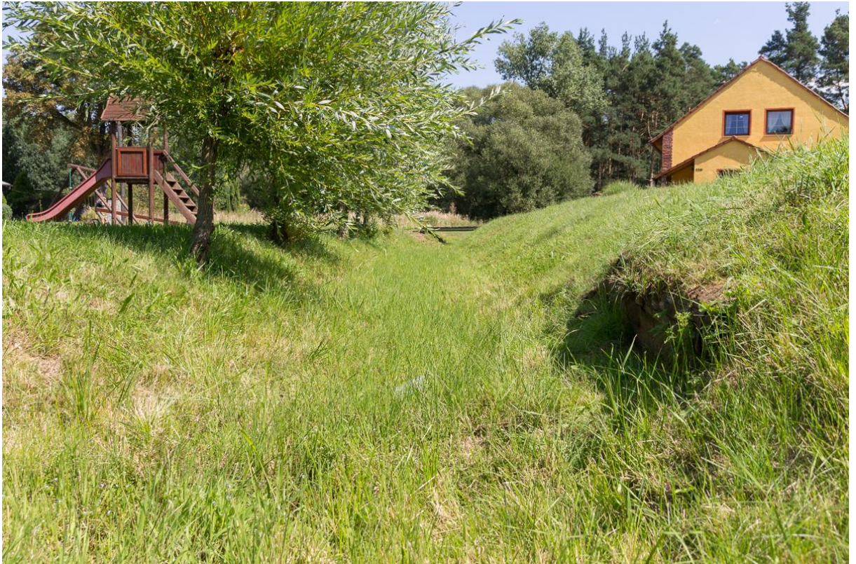
LUC007 – Technicky upravený úsek v podobě zatravněného průlehu v chatové osadě Větrná Jáma
