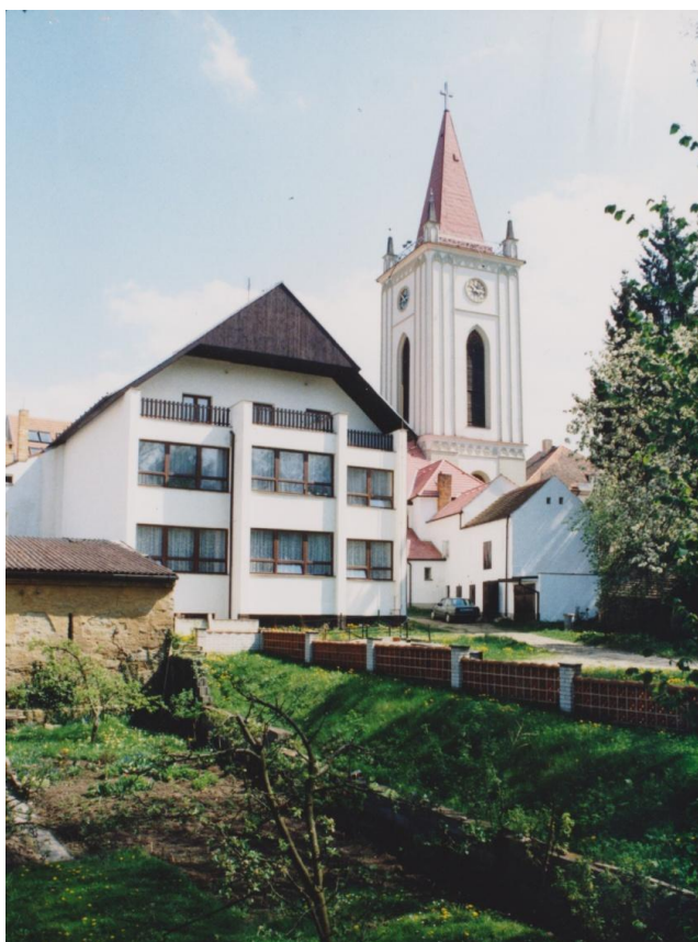
Obrázek 2: Nová část školní budovy
