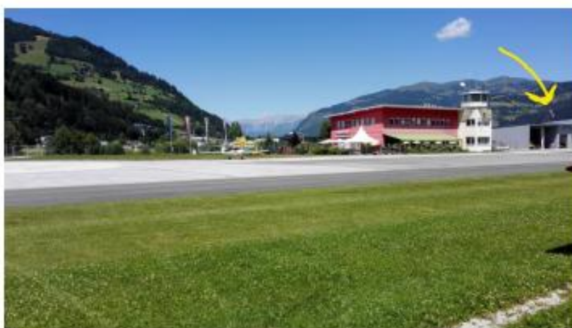
Obr. 7: Větrný rukáv na střeše hangáru [REDACTED]
