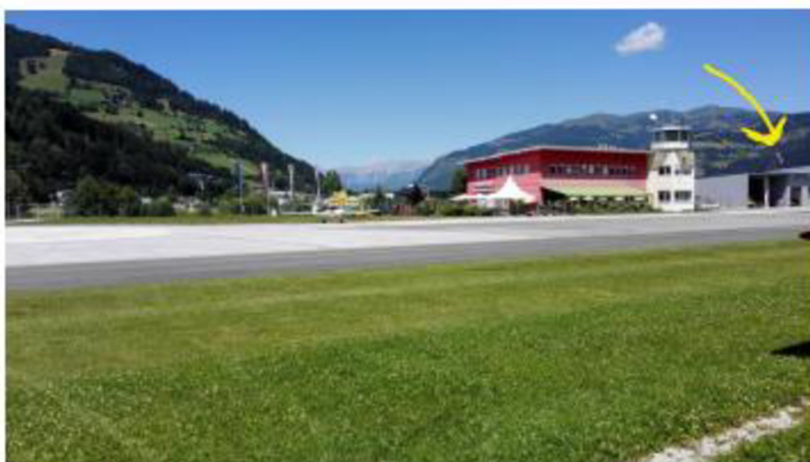
Obr. 7: Větrný rukáv na střeše hangáru
