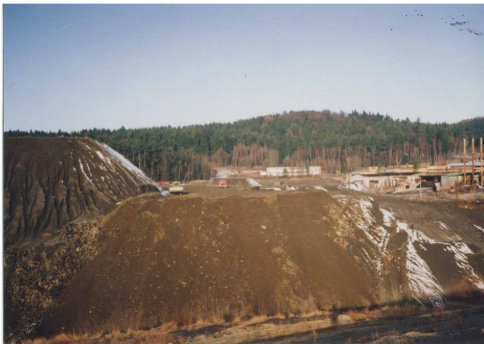
Foto 2: Severní část odvalu Olší před technickou rekultivací (březen 1992, archiv s. p. DIAMO)
