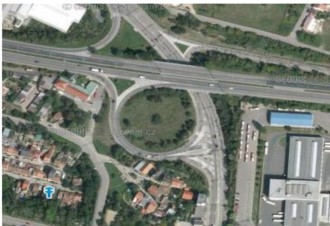
Obrázek 55 Podjezd pod silnicí Ostravská
