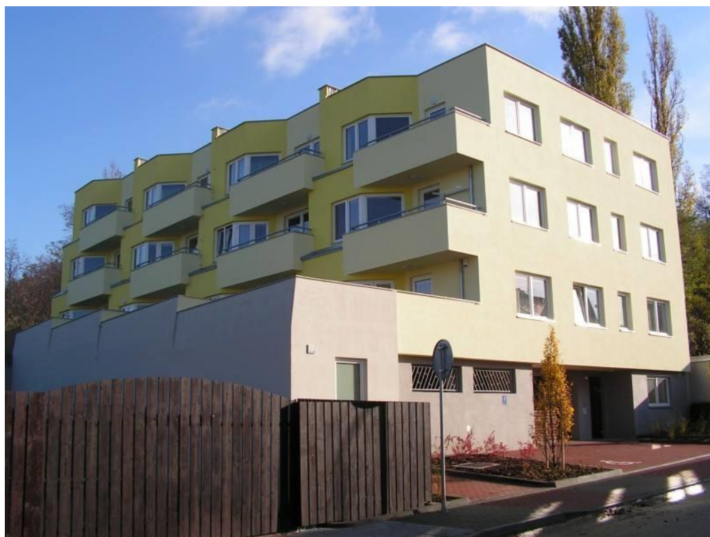
Obrázek 1 Bytový dům Bílá hora
