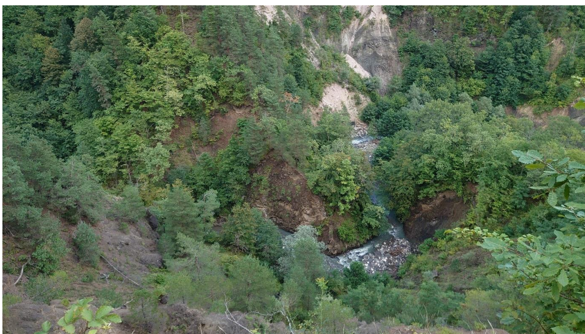
Obr. 43 – Problémový úsek na trase přivaděče
