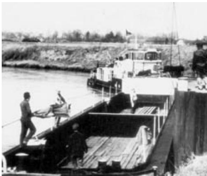
Obr. č. 25.a: Říční přístav na řece Odře z roku 1975 (zdroj: Společnost Poodří, 2006)
