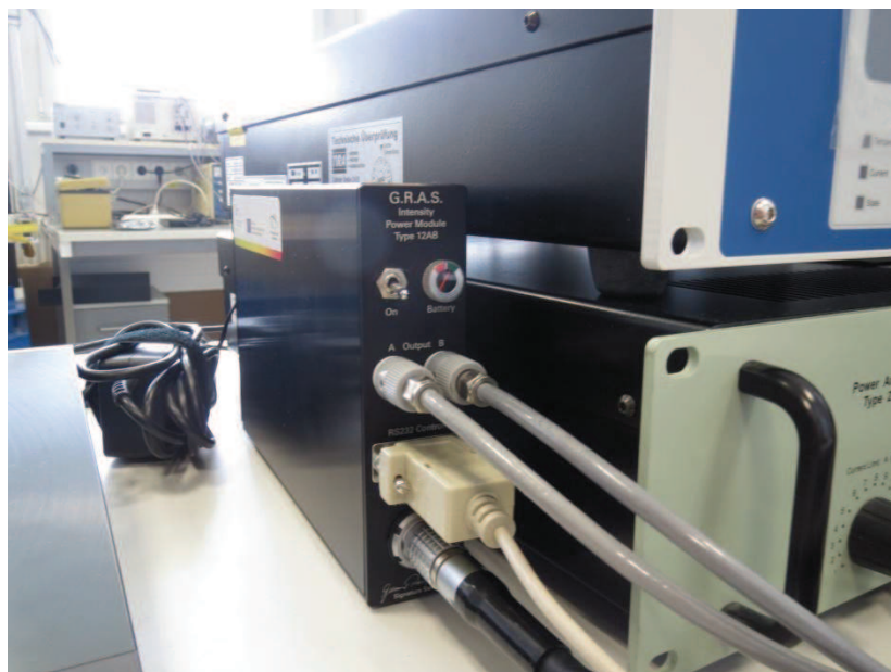
Obrázek 21: Napájecí modul G.R.A.S. 12AB pro intenzitní sondu s připojenou sondou, komunikací RS232 a výstupy zapojenými do NI PXI 4461
