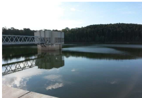
Obr. č. 3 – VD Římov (foto: autor)
