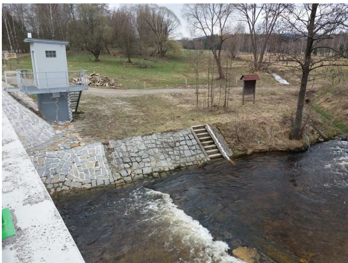
Příloha č. 8 – Hydrologická stanice (limnigraf) Černá - Líčov, ř.km 9,235 (foto: autor, 2019)
