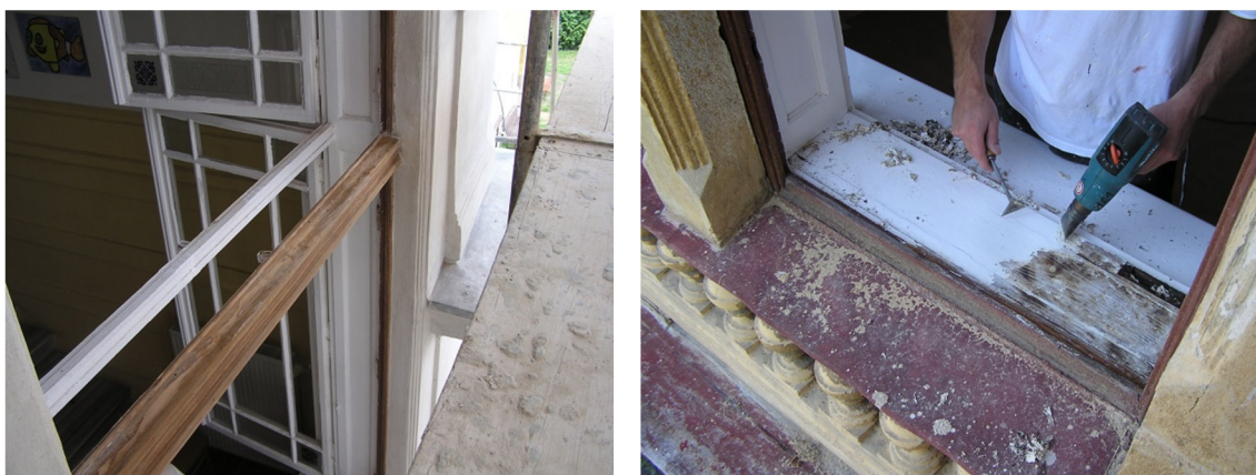
Obrázek 10 – Oprava původních dřevěných oken, [Autor]
