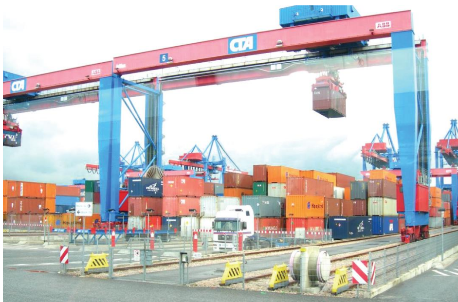
Obr. 29 Automatizovaný jeřáb RMG [8]
