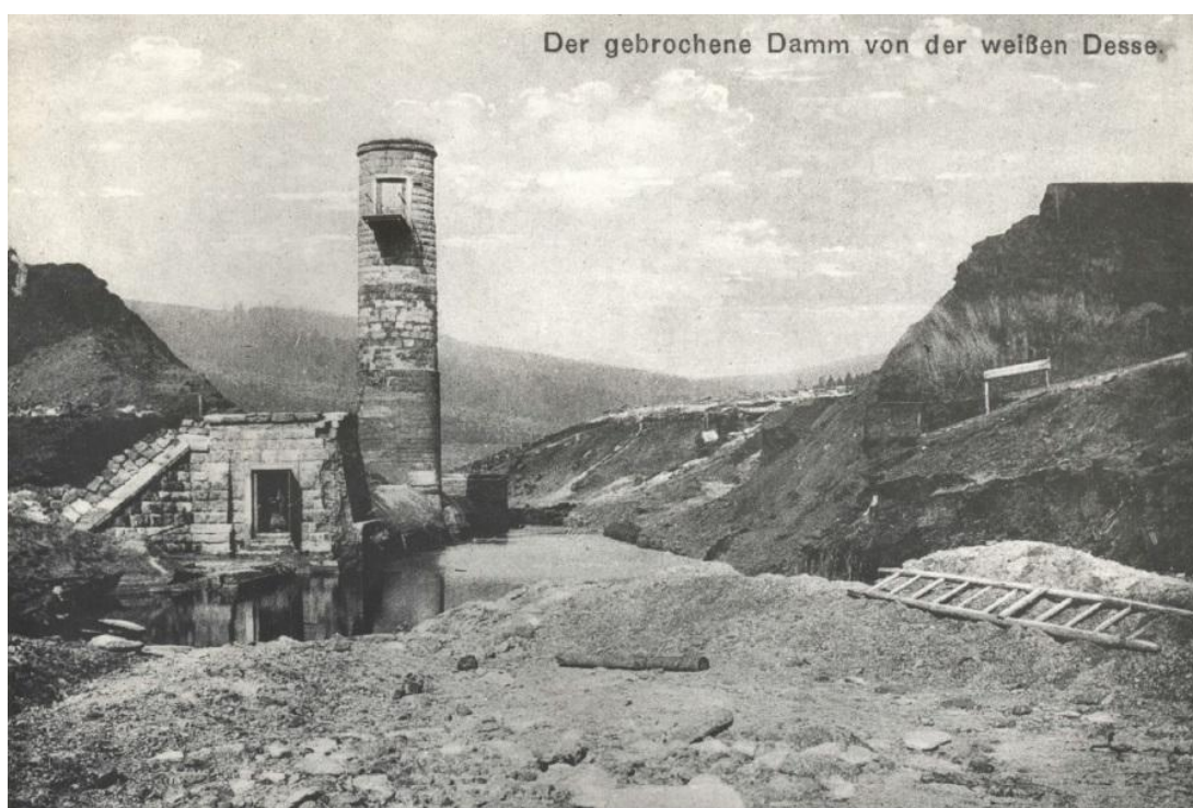
Obr. č. 5: Pohled na hráz po jejím protržení roku 1916 (zdroj: převzato z publikace Der Dambruch der Talsperre an der Weissen Desse am 18. September des Kriegjahres 1916.)
