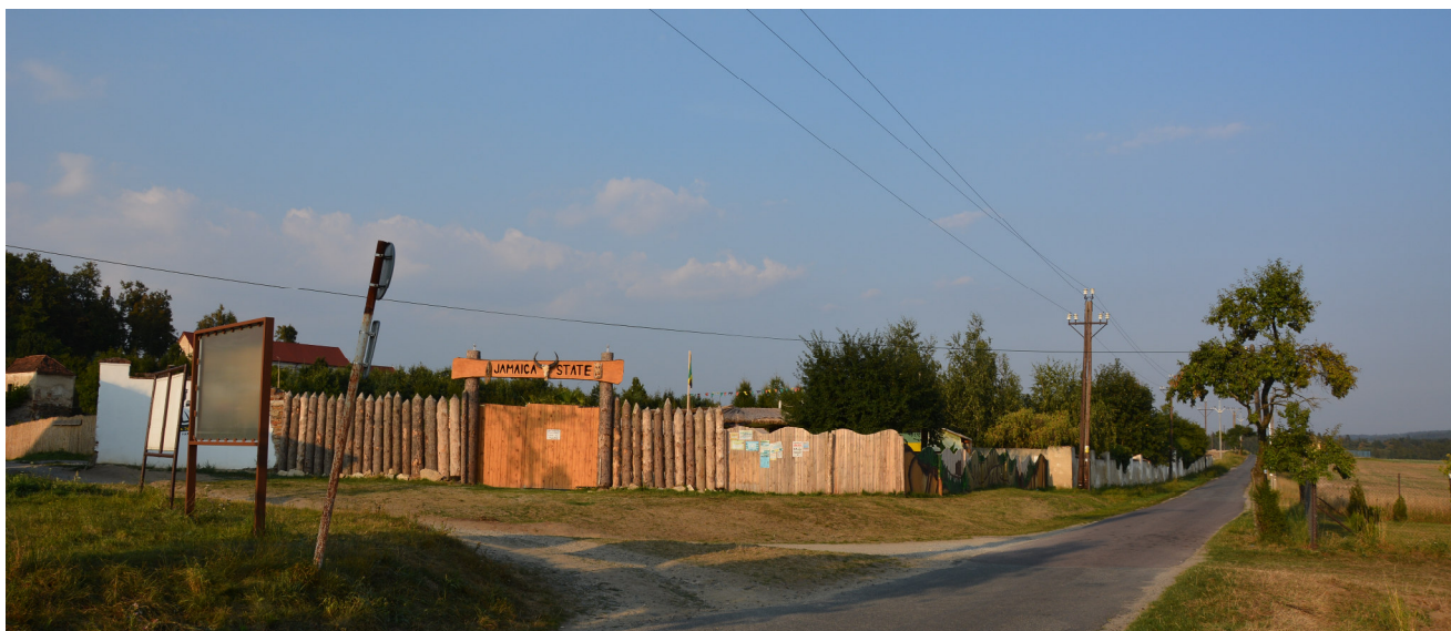
Obrázek 5: Současná podoba areálu barokního velkostatku Vranč, pohled na přístupovou cestu a bývalé zahrady
