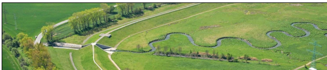
Obr. 14: Poldr Žichlínek, retenční nádrž a revitalizace toků (sindlar.cz)
