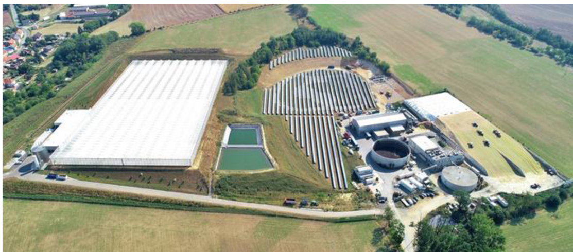
Obr. 2.5 Bioplynová stanice a skleník ve Smržicích [5]
