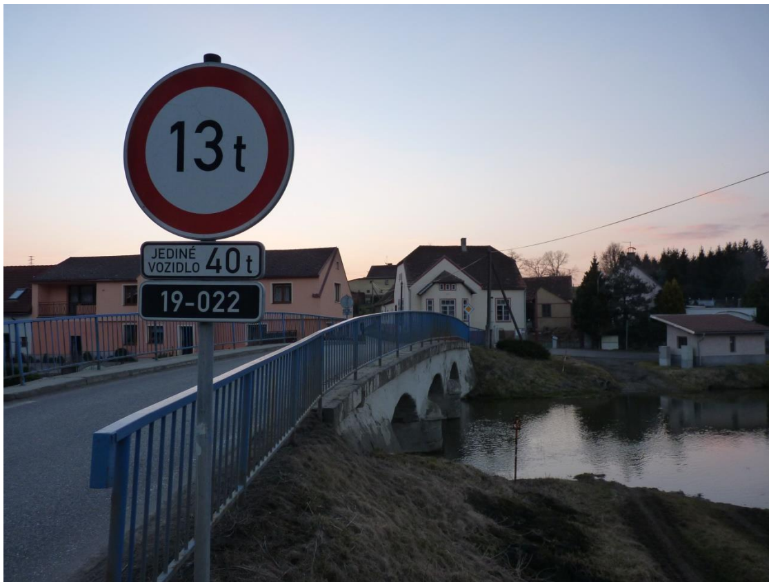
Most v obci Počaply:
