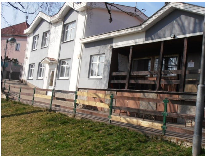
Obr. 3.1.2 Budova sloužící k ubytování klientů
