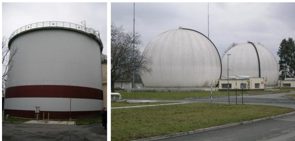
Obr. 7 Anaerobní stabilizační nádrž (vlevo) a zásobníky bioplynu (vpravo)
