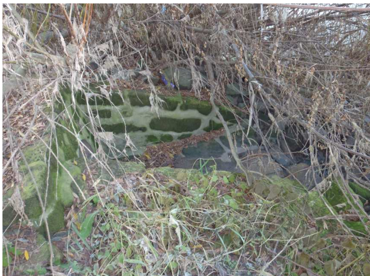
foto č. 9 Kanalizační výust' - DC18 (zdroj: vlastní)
