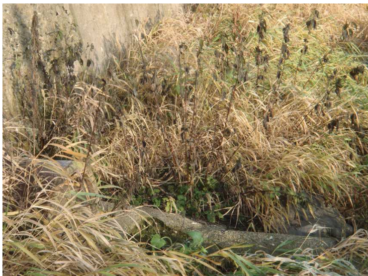
foto č. 2 Kanalizační výúst' - DC2 (zdroj: vlastní)
