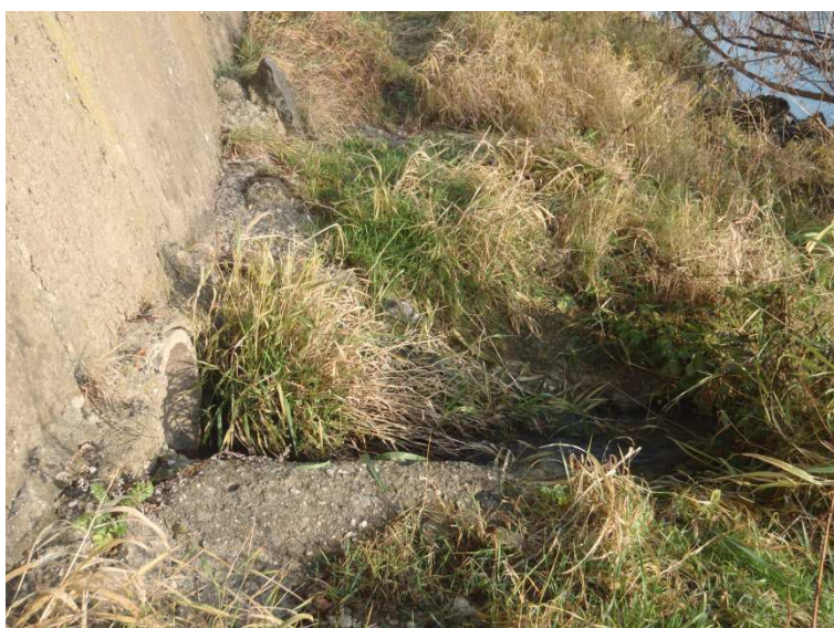
foto č. 3 Kanalizační výúst' - DC3 (zdroj: vlastní)
