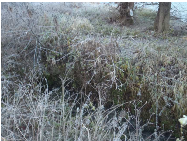
foto č. 8 Kanalizační výust' - DC9 (zdroj: vlastní)
