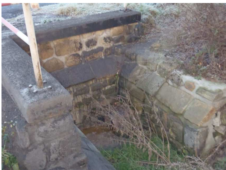
foto č. 10 Kanalizační výust' - DC28 (zdroj: vlastní)
