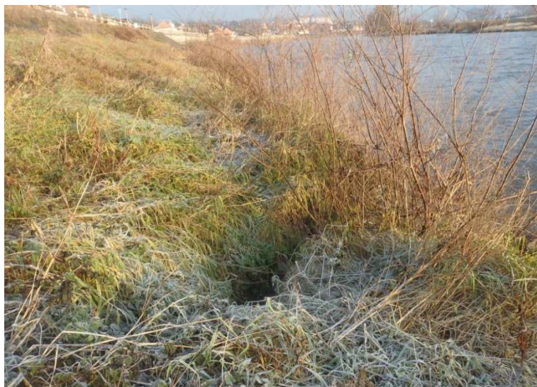
foto č. 1 Kanalizační výúst - DC1 (zdroj: vlastní)
