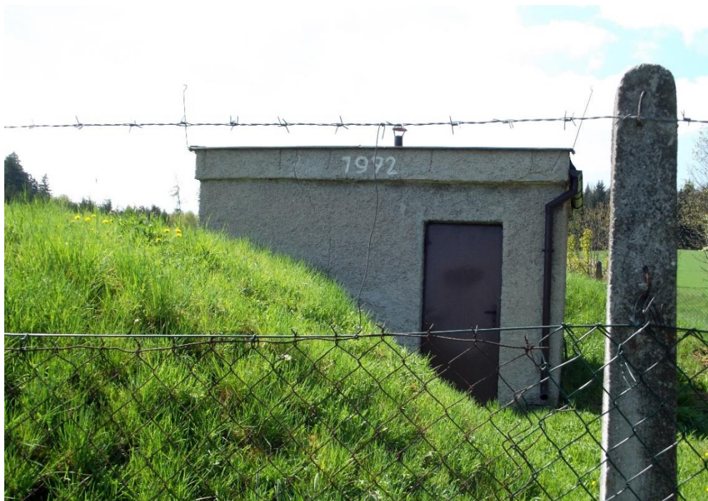
Obr. 2.4 Vstup do armaturní komory zemního vodojemu Hrádek.
