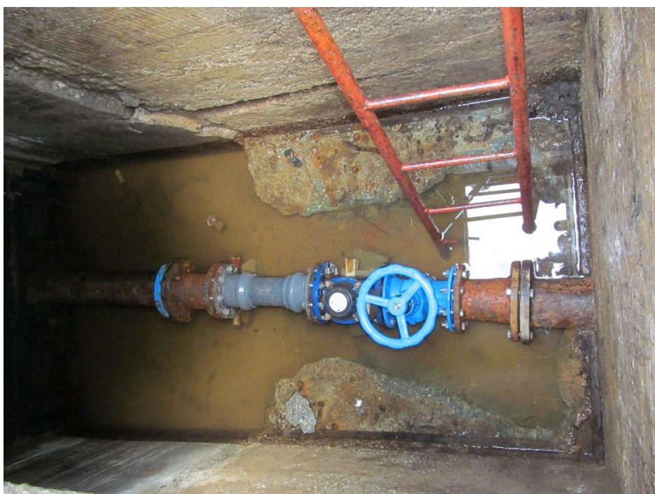
Obr. 2.7 Vystrojení armaturní šachty „U nádraží“.
