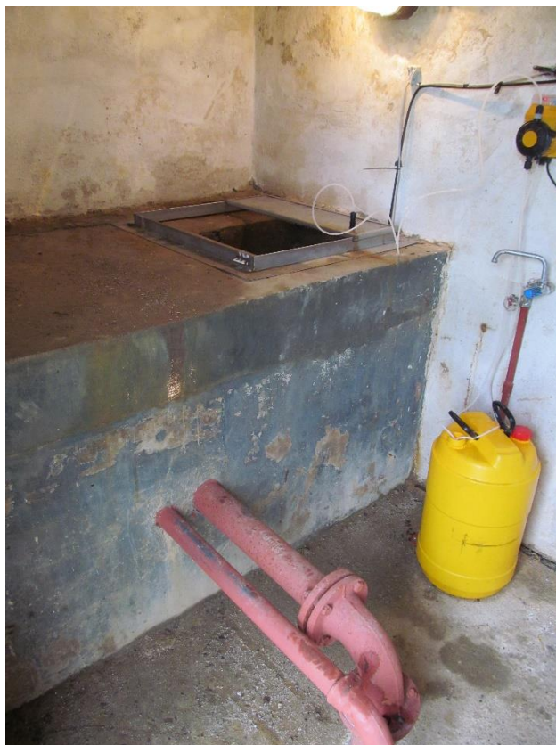
Obr. 2.5 Dávkování dezinfekce a odvětrání akumulční komory.
