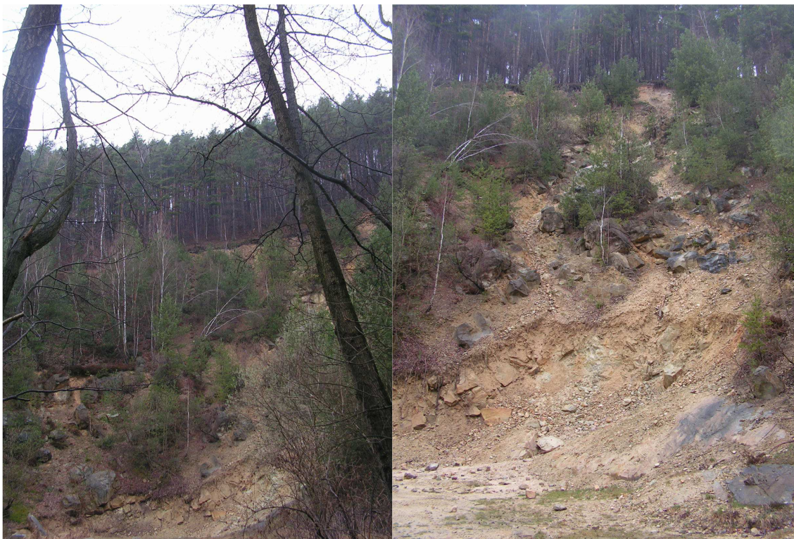
Obr. č. 60 a 61: Sesuv flyšových hornin v lokalitě Pradliska (foto: Filip Machula, březen 2010)
