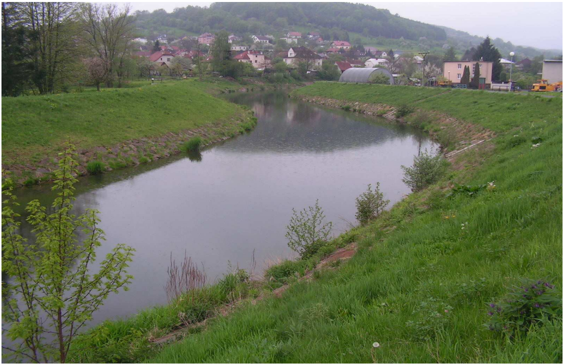
Obr. č. 79: Regulované koryto Dřevnice v lokalitě Lůžkovice (foto: Filip Machula, duben 2010).
