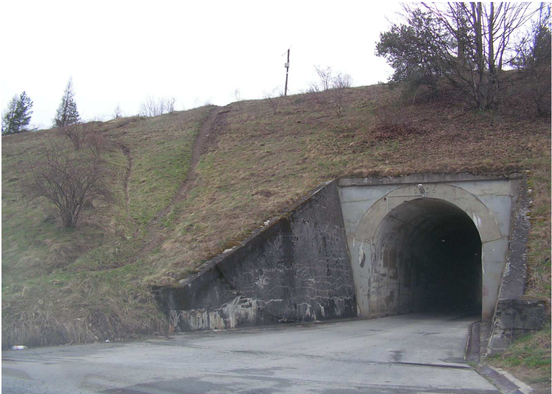
Obr. č. 89: Baťův železniční násep v lokalitě Lutonina (foto: Filip Machula, březen 2010)
