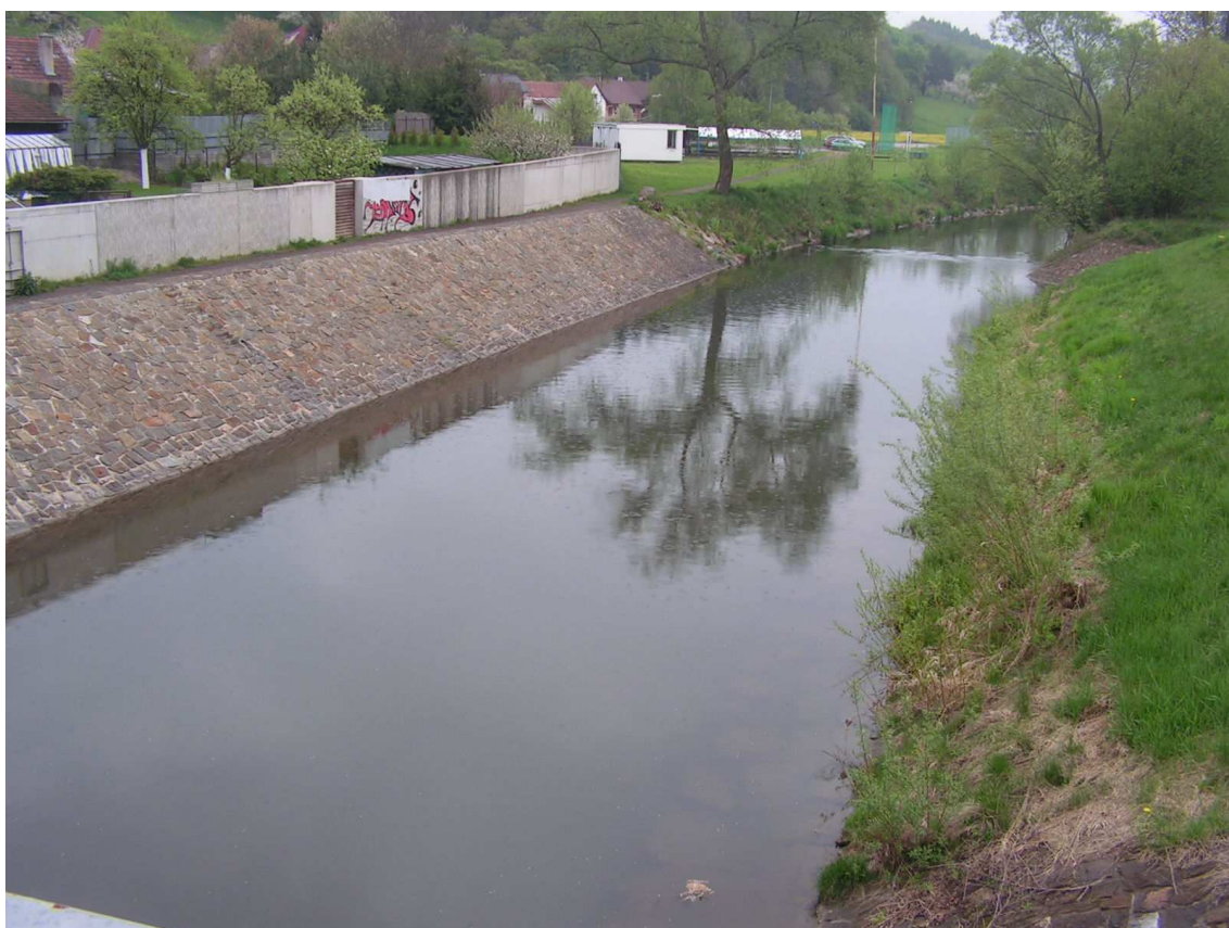
Obr. č. 24: Pískovcové bloky zasazené do břehu chrání před vznikem břehových nátrží v lokalitě Zlín – Lůžkovice (foto: Filip Machula, duben 2010)
