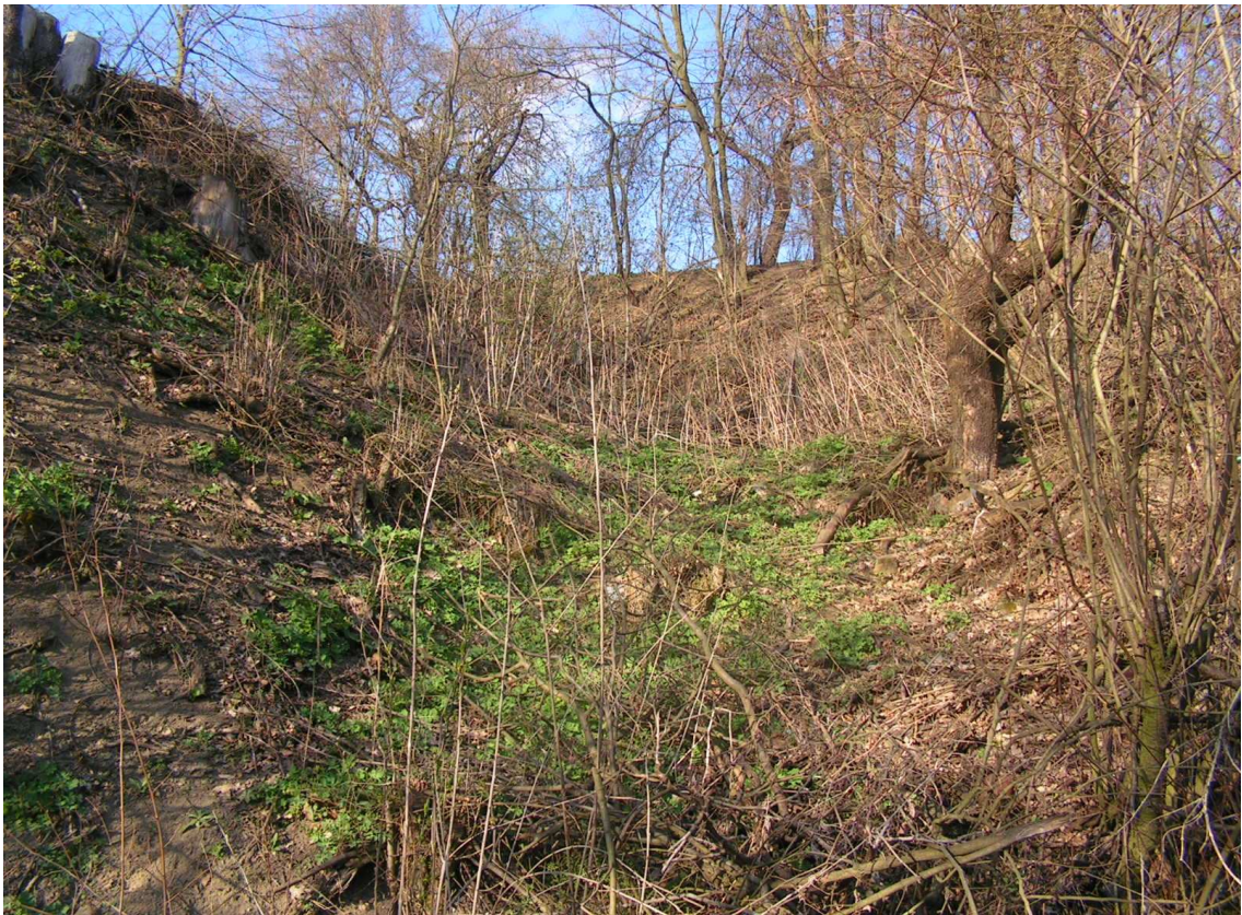
Obr. č. 30: Svahová strž se po směru odtoku povrchové vody rozšiřuje (foto: Filip Machula, březen 2010)
