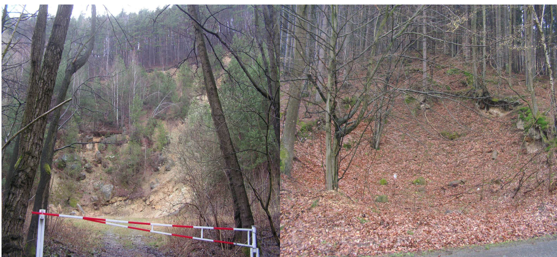
Obr. č. 62 a 63: Sesuv flyšových hornin v lokalitě Pradliska (foto: Filip Machula, březen 2010)
