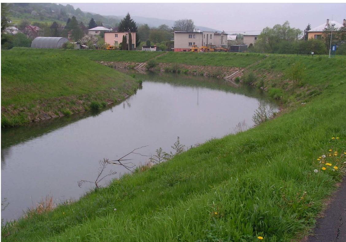
Obr. č. 82: Koryto regulované Dřevnice v lokalitě Lůžkovce (foto: Filip Machula, duben 2010).
