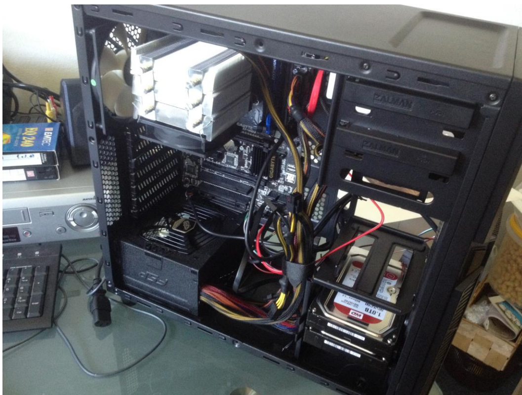
Obr. 13. : Server před prvním spuštěním bez RAID 5 pole.
