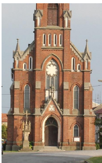
Obr. 20: Pohled z východu na fasádu kostela sv. Bartoloměje, 1909, Polkovice
