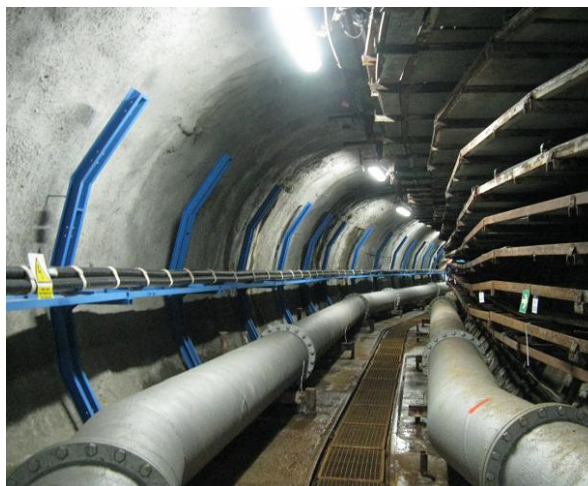
Obrázek 3-2 Uložení kabelového vedení 110 kV v kolektoru [2]
