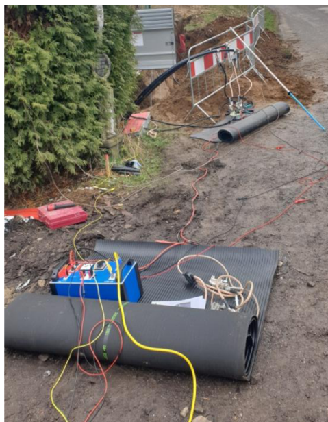
Obrázek 7-12 Připojení měřicí soustavy ke zkoušenému vedení
