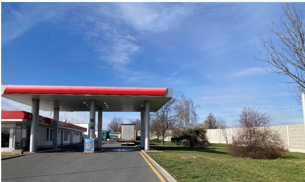
Příloha č. 8: Fotografie – Odpočívadlo Újezd – ČSPH + východní část první zelené plochy
