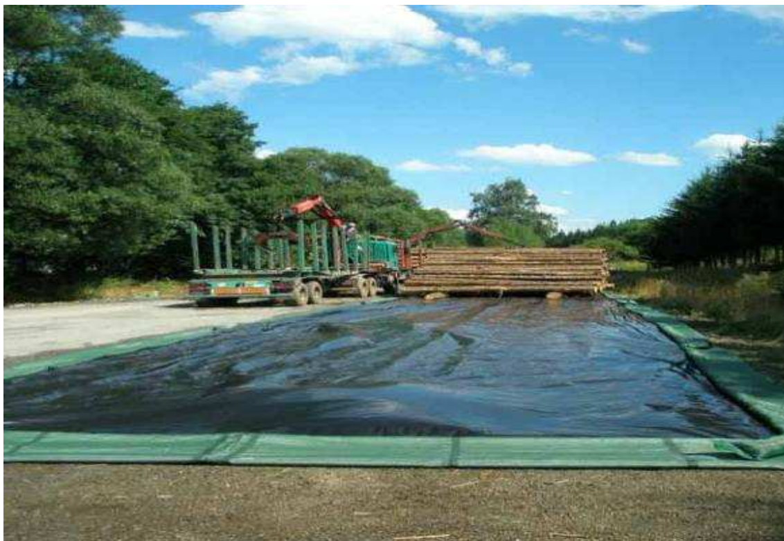
Obr. č. 1 – Ochranná síť ovina a na ni položená fólie
