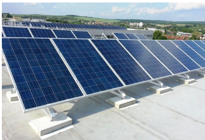
Obrázek 16: Konstrukce zatížená betonovými deskami
