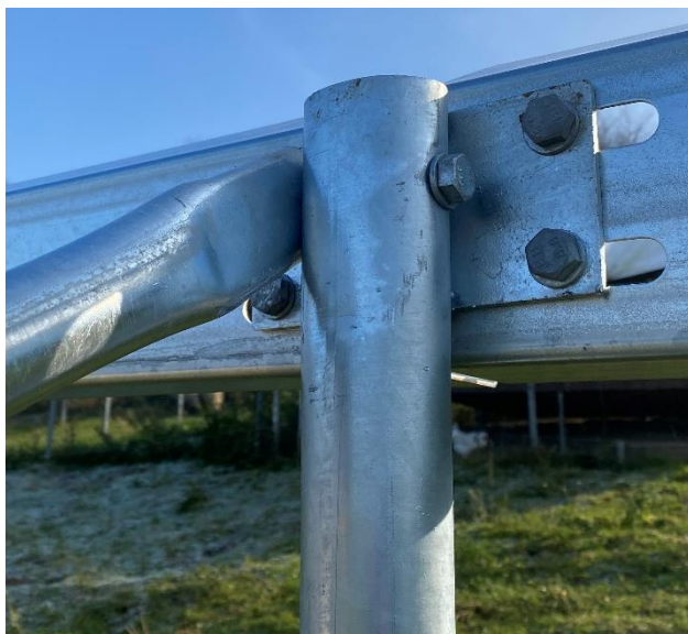
Obrázek 37: Uchycení vzpěry k zadní stojině
