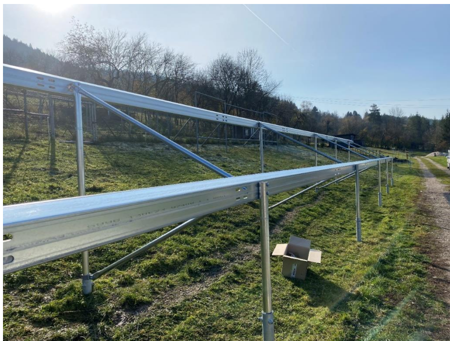
Obrázek 38: Inovovaná konstrukce z ocelových dílů
