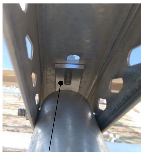
Obrázek 29: Uchycení hliníkového profilu ze spodu
