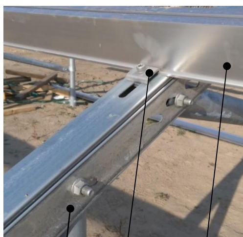
Obrázek 28: Uchycení hliníkového profilu shora
