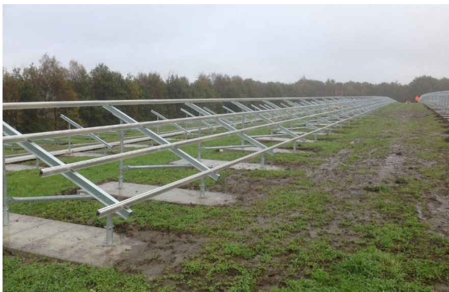
Obrázek 19: Betonové základy s nosnou konstrukcí pro FV panely
