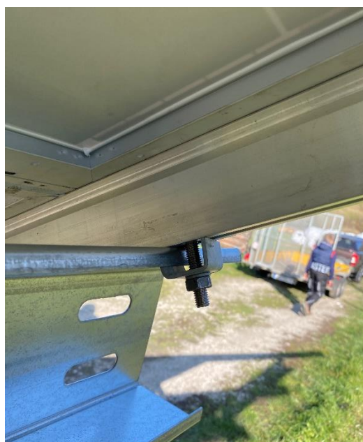
Obrázek 45: Uchycení hliníkového profilu k vaznici
