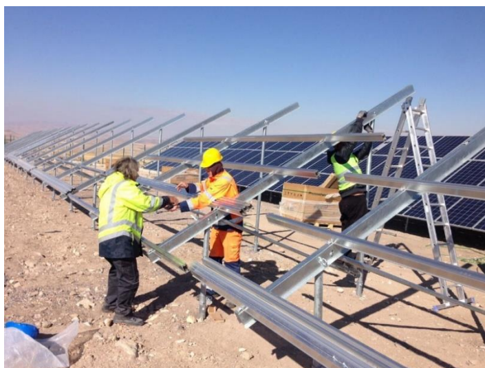
Obrázek 30: Montáž hliníkových profilů
