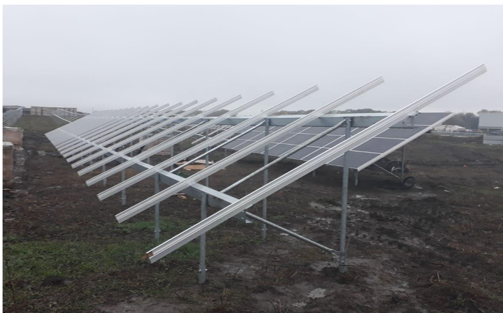
Obrázek 40: Hliníkové profily připevněné k ocelové konstrukci
