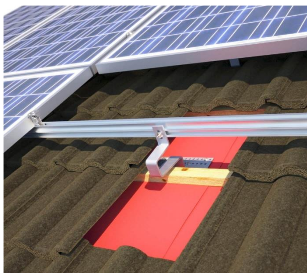
Obrázek 13: Uložení střešního háku
