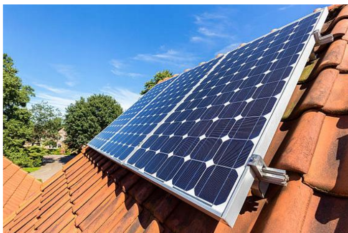
Obrázek 12: Upevnění fotovoltaických modulů na šikmou střechu
