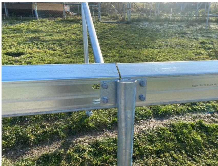
Obrázek 35: Spojení vaznic pomocí stojiny
