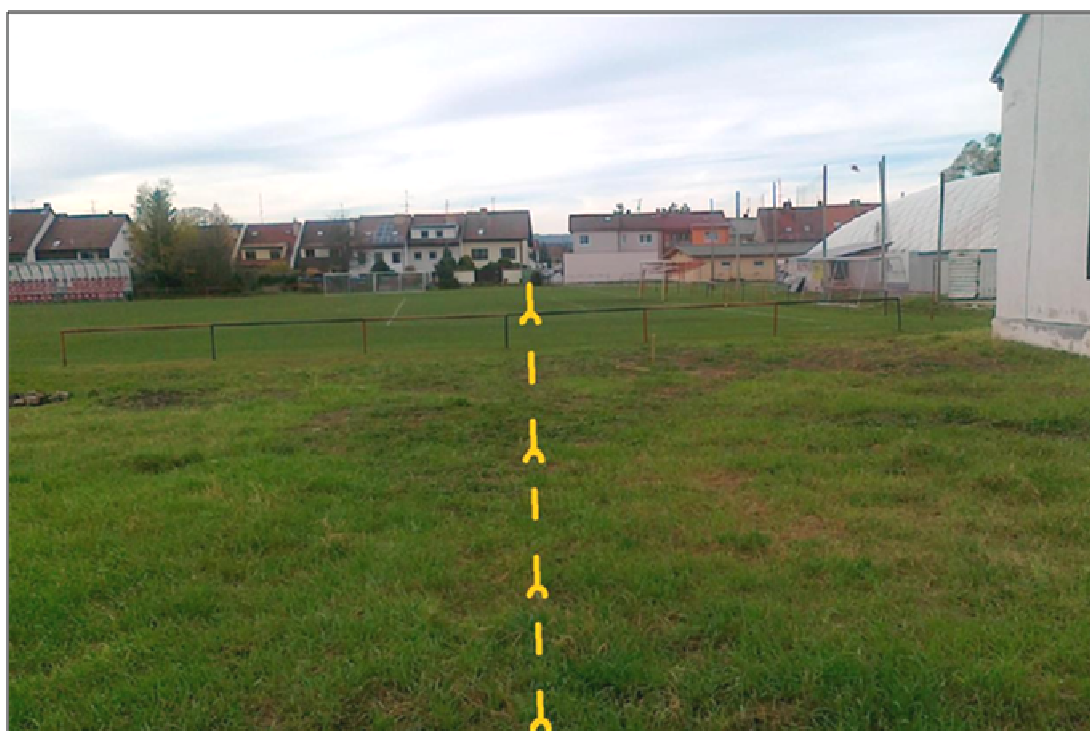
foto č. 2 Pohled po spádu stávajícího sběrače vedeného přes hřiště, trasa zakreslena žlutě
