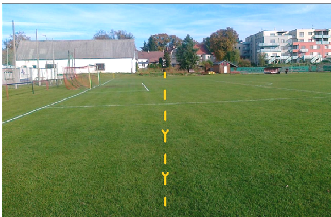
foto č. 1 Pohled proti spádu stávajícího sběrače vedeného přes hřiště, trasa zakreslena žlutě
