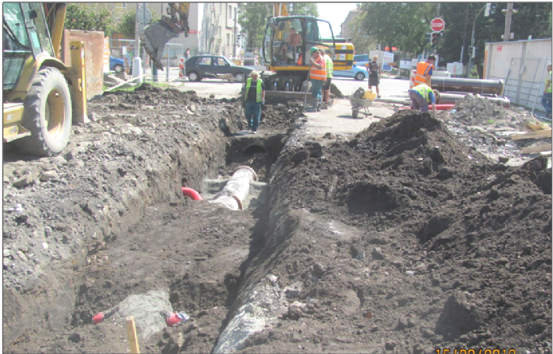
foto č. 3 Čechova II – obetonované kameninového potrubí DN 400
