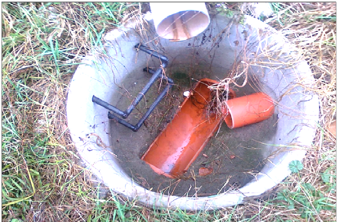
foto č. 8 Stávající šachta dešťových vod z firmy Anipol s.r.o. Odtok do navrhovaného sběrače PVC DN 200
