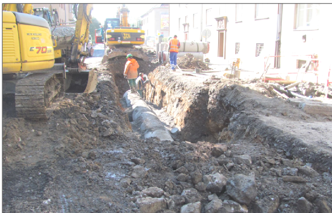
foto č. 2 Čechova I – železobetonové porubí DN 600, spádované do Žižkovy třídy
