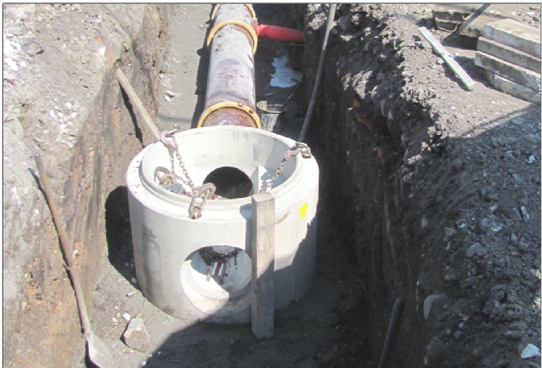
foto č. 4 Čechova II – kameninového potrubí DN 500, prefabrikované šachtové dno
