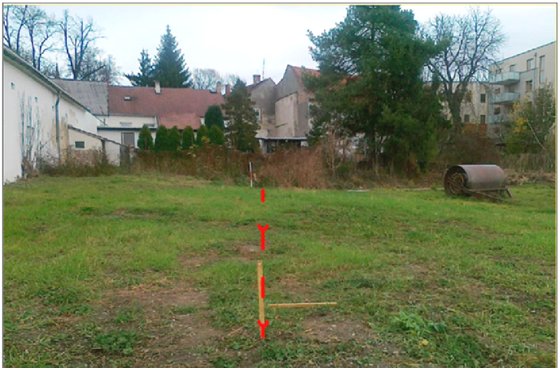
foto č. 6 Pohled proti spádu navrhovaného sběrače od Š4 (kolík) k stávající šachtě (výtyčka), trasa zakreslena červeně
