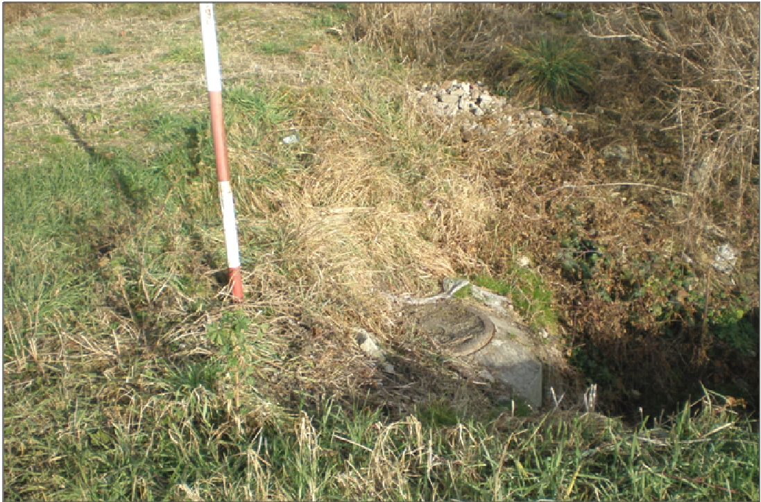
foto č. 7 Stávající kanalizační šachta- konec rekonstrukce kanalizace
