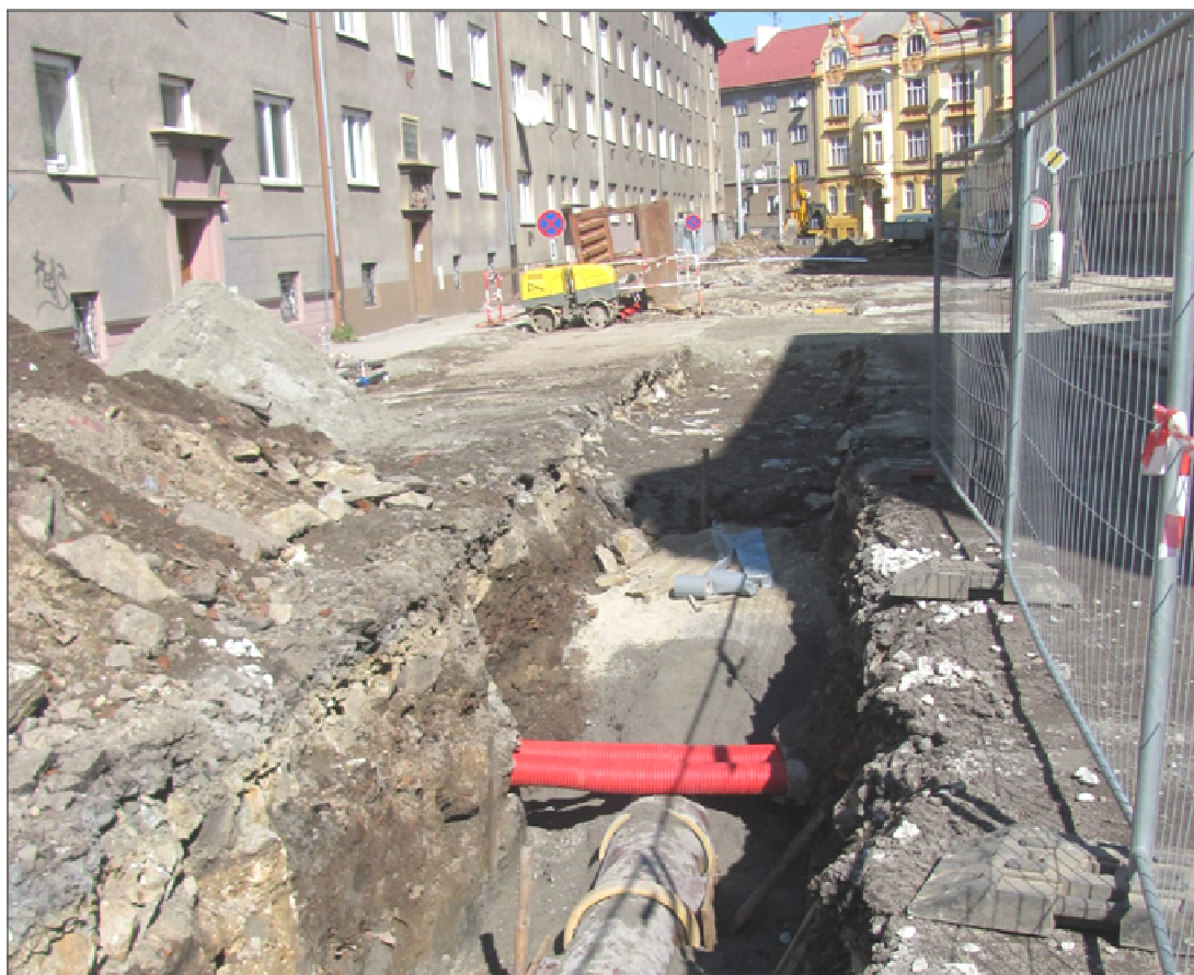
foto č. 1 Čechova I – kameninového potrubí DN 500, šedá folie nad potrubím
